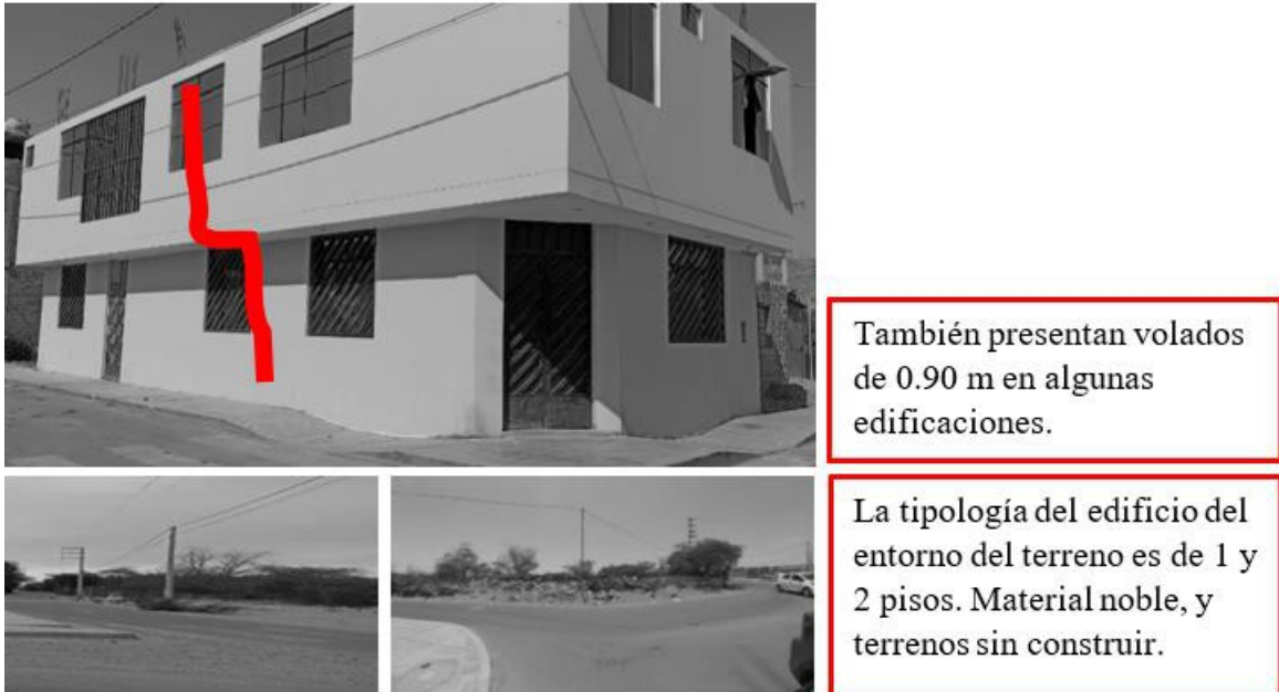
Figura N°19: Tipología de edificatoria
