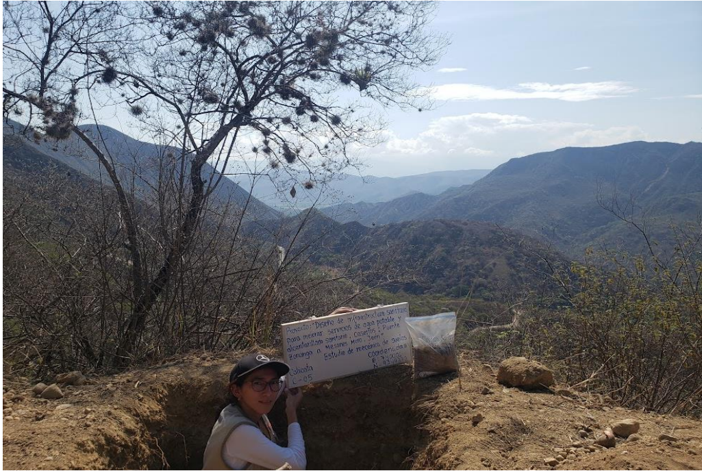
Figura 5. Calicata N°05- tramo conducción
