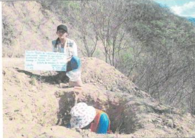
Excavación de Calicata C-3
