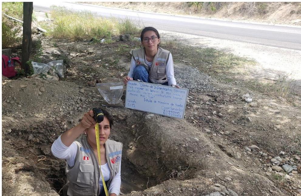
Figura 10. Calicata N°12- tramo conducción
