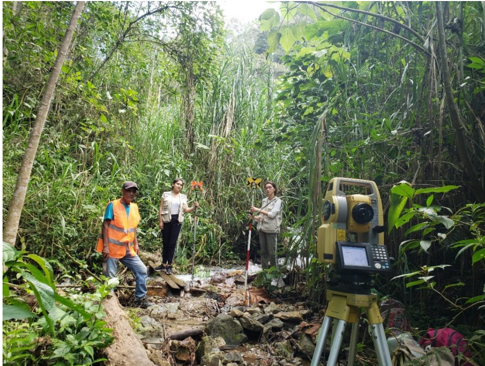
Figura 1. Inicio del levantamiento topográfico- captación
