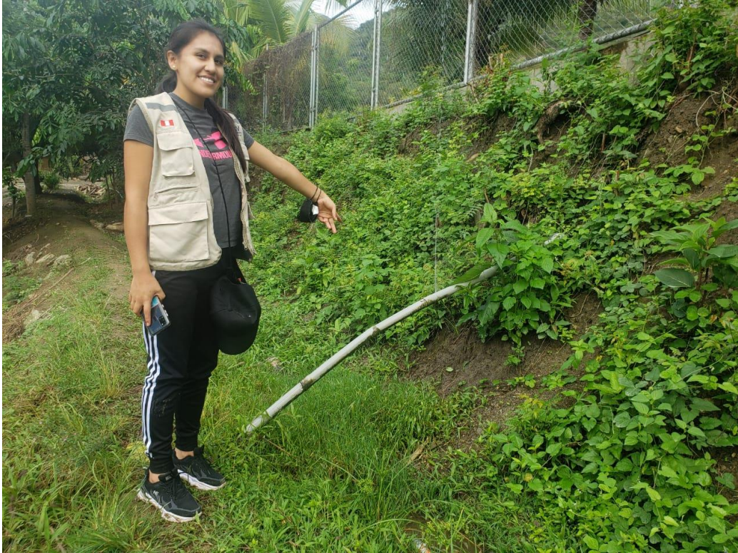
Anexo 4. Tubería de la institución educativa del caserío Puente Zonanga
