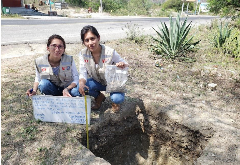
Figura 11. Calicata N°14- tramo conducción
