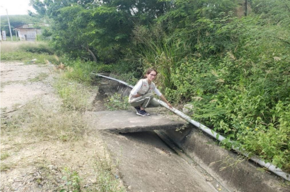
Anexo 5. Tuberías que llevan agua no apta para el consumo humano al caserío Buena Esperanza
