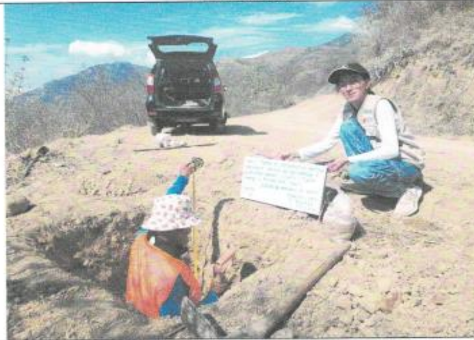
Excavación de Calicata C-2
