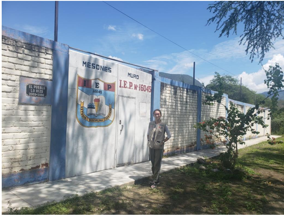
Figura 6. Institución educativa N° 16045, caserío Mesones Muro.
