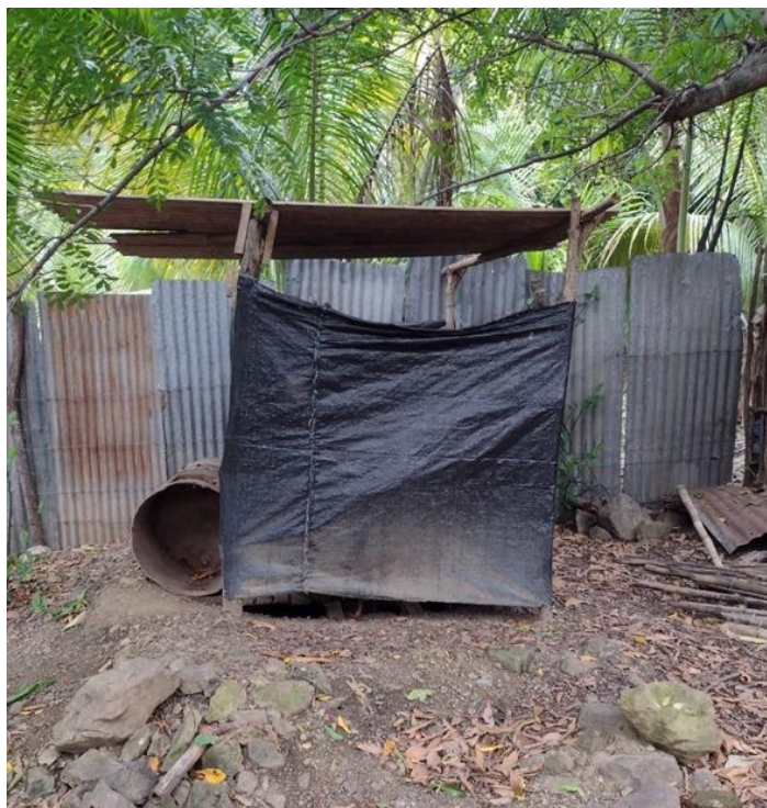
Anexo 8. Servicios higiénicos del caserío Puente Zonanga
