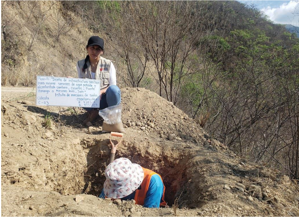
Figura 3. Calicata N°03- tramo conducción
