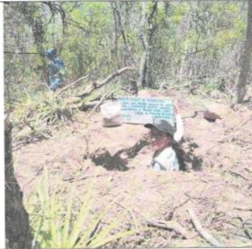
Excavación de Calicata C-8
