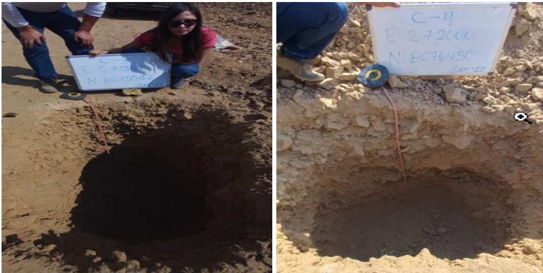
Figura 5: Excavación Calicatas Fuente: Elaboración Propia
