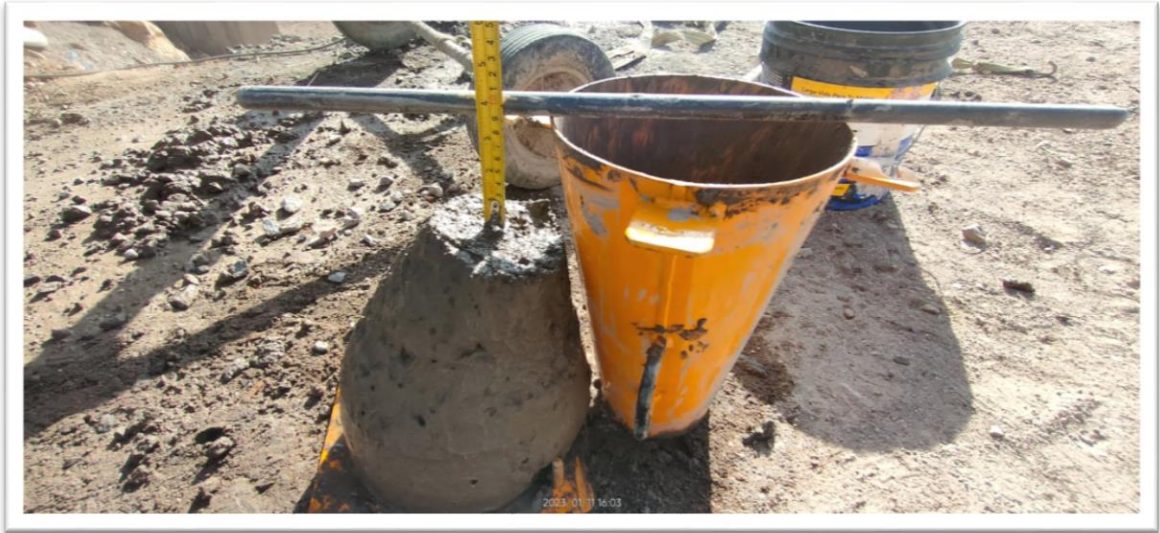
Fotografía 16: medición del asentamiento
