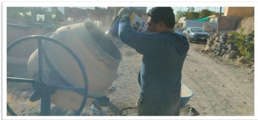
Fotografía 11: preparación del concreto
