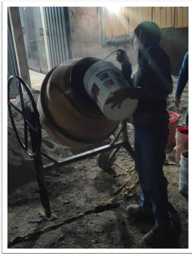
Fotografía 10: elaboración del concreto
