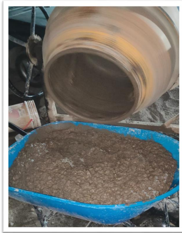
Fotografía 12: concreto listo para su colocación en probetas
