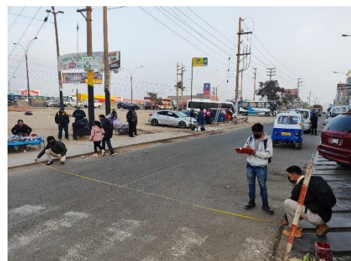
Toma de datos correspondiente al levantamiento topográfico.
