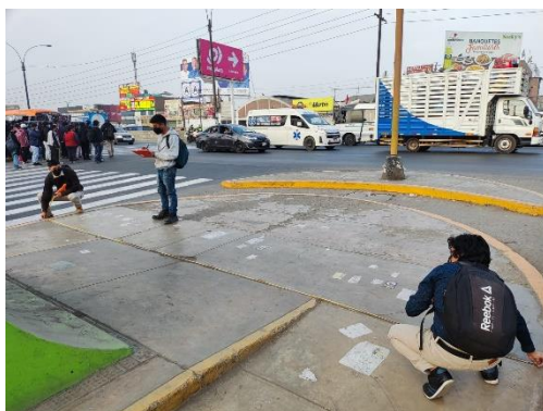
Toma de datos correspondiente al levantamiento topográfico.
