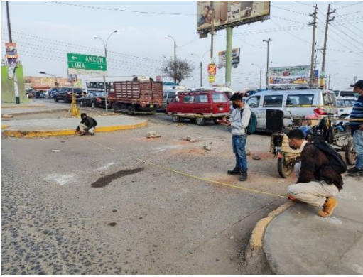
Toma de datos correspondiente al levantamiento topográfico.
