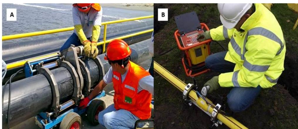
*Nota:* A) Soldadura por termofusión a tope, B) soldadura por electrofusión. Fuente: Adoptado de Innovación en Geosintéticos y construcción (2023).
