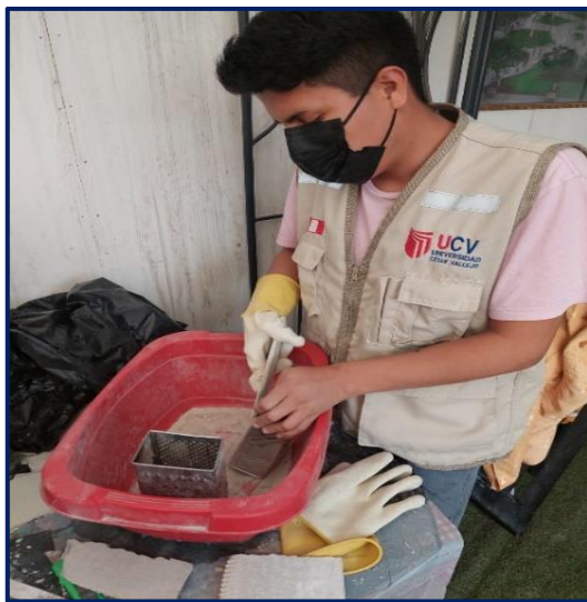
Figura 31. Rayado manual del fibrocemento en in situ.
