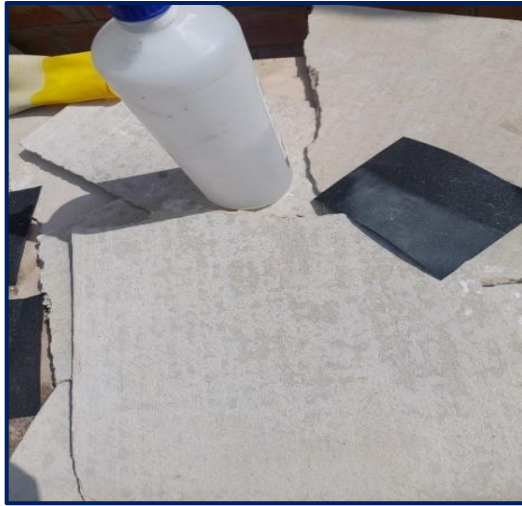
Figura 30. Fracturamiento manual del fibrocemento.
