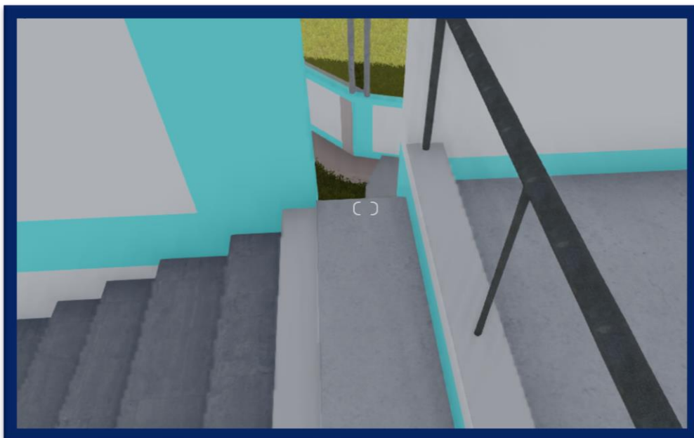
Imagen 28: Abertura entre segundo piso y escaleras.
