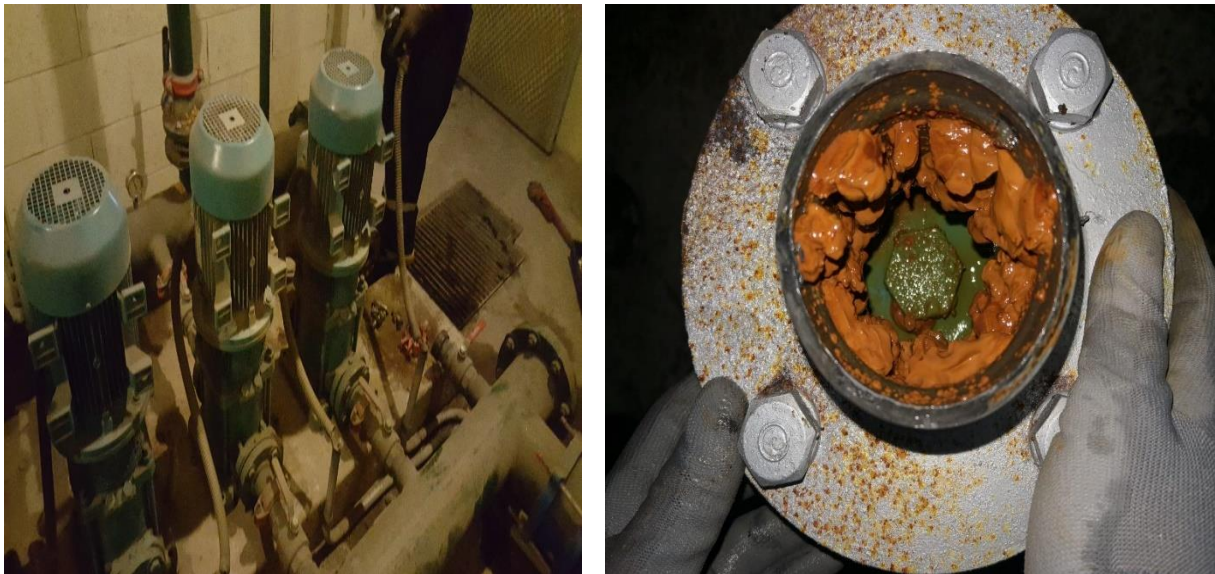
Figura 7. Sistema de bombeo (1A)
