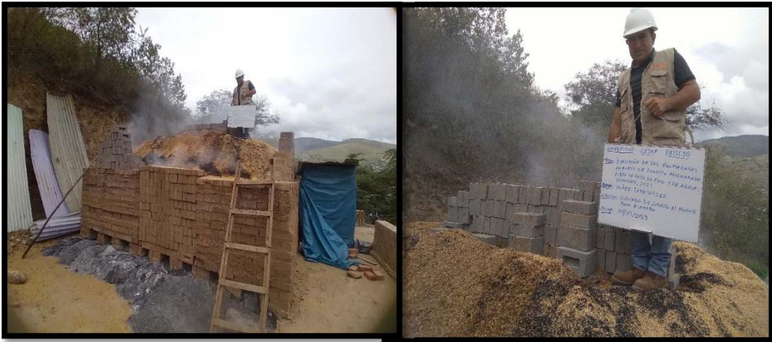
**Colocado de ladrillo artesanal al horno para quemado.**
