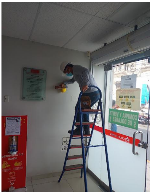
Figura 33. Ejecución mantenimiento preventivo.
