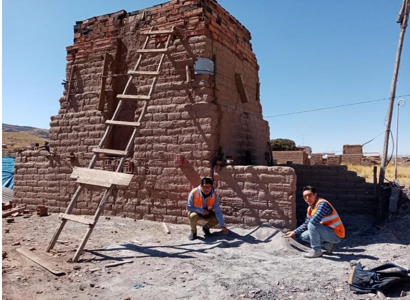
Figura. 8. Remanente de hornos artesanales en los que se contienen partículas de ladrillos y ceniza (producto de la quema de carbón y estiércol de animales). Fuente: personal
