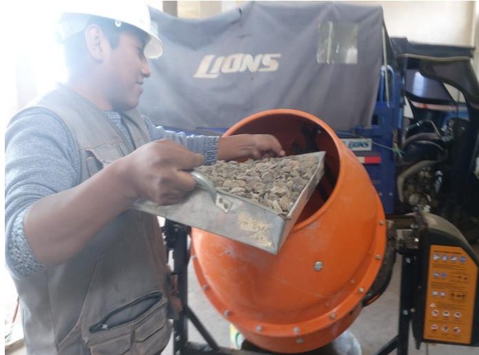
Figura 3. Preparación del concreto permeable Fuente: Toma propia
