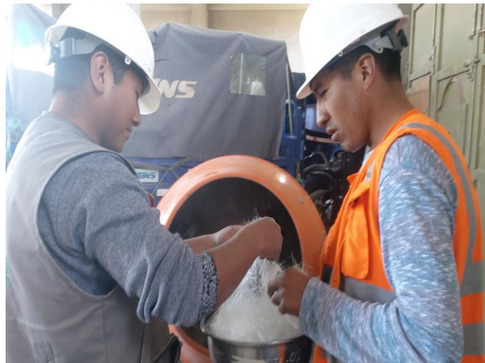
Figura 4. Dosificación de fibra de vidrio en la preparación del concreto Fuente: Toma propia
