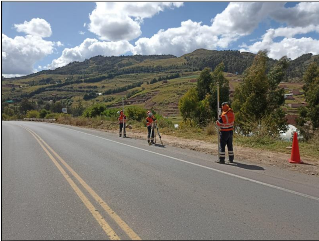
Ilustración 8: Se evidencia al equipo técnico de topógrafos realizando trabajos de nivelación.
