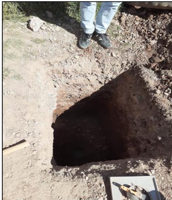
Ilustración 11: Se evidencia la excavación y toma de muestras de la Calicata C-03. Fuente: Elaboración Propia.
