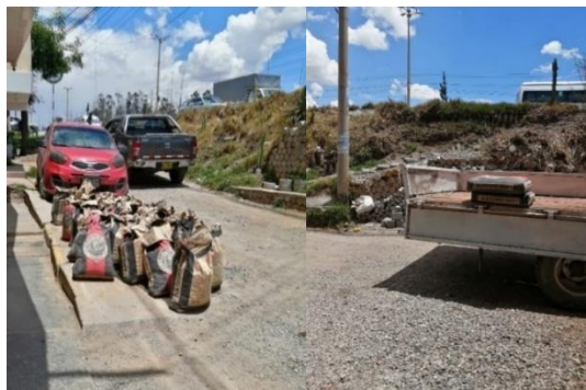
Figura 14. Recepción del agregado grueso, piedra chancada y cemento
