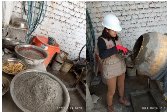
Figura 31. Elaboración de mezcla de concreto con adición de sisal
