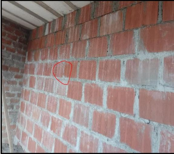
**Figura 146:** Muro portante con ladrillo blocker.
