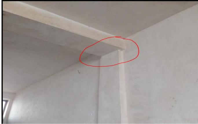
**Figura 183:** El ancho de la viga sobre sale a la dimensión de la columna.
