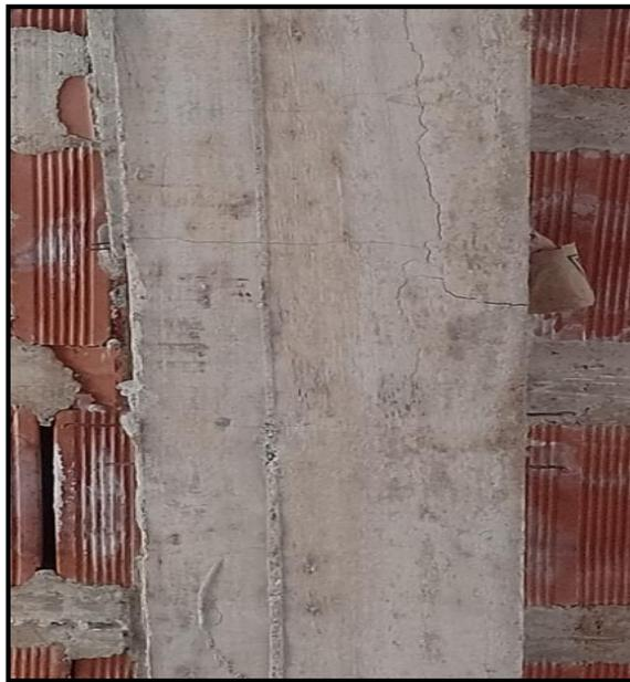
**Figura 158:** Fisuras en la viga.
