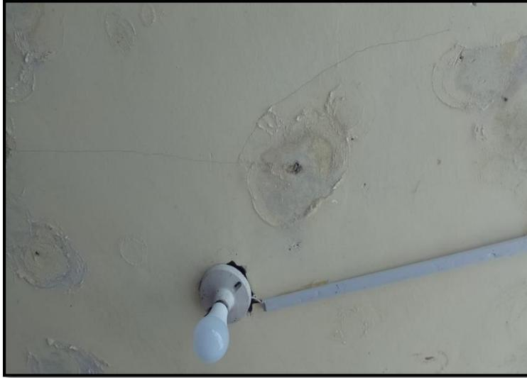
**Figura 217:** Fisura en techo.
