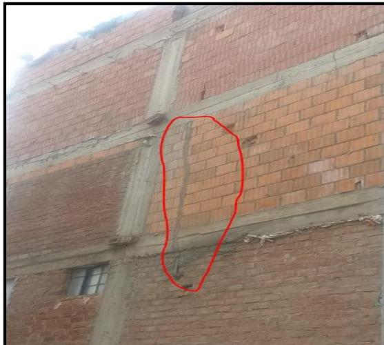
**Figura 194:** Muro y viga atravesado por la tubería de agua potable.
