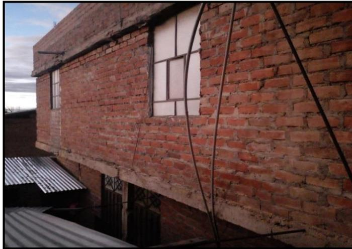
**Figura 20:** Muro mal fraguado con concreto.
