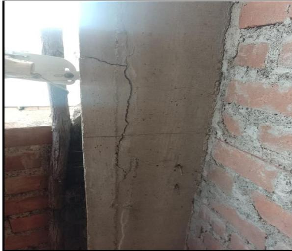
**Figura 125:** *Rajadura en columna (forma diagonal).*
