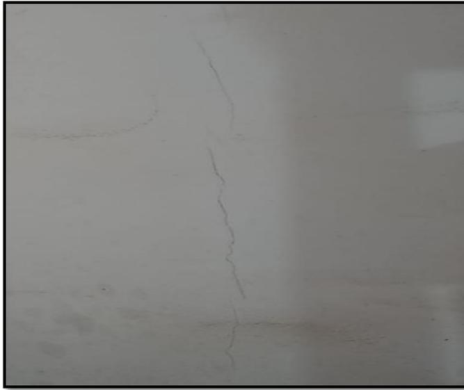
**Figura 205:** Fisuras en la columna.
