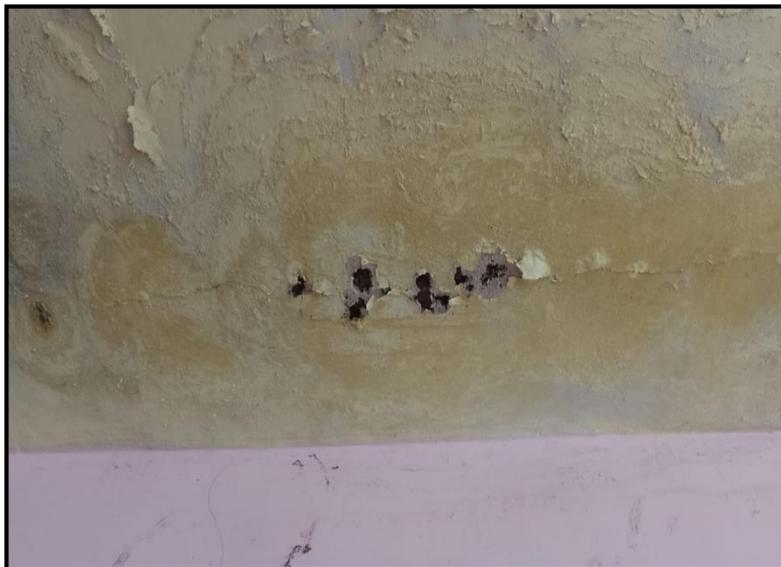
**Figura 228:** Eflorescencia y filtraciones de agua.
