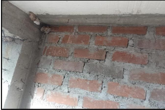
**Figura 114:** *Rajadura en muro (forma diagonal).*
