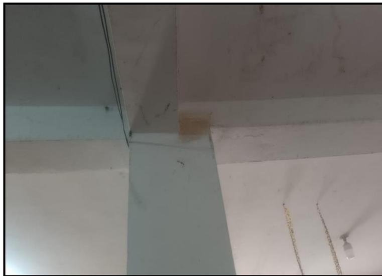
**Figura 26:** La viga no está alineada al eje de la columna.
