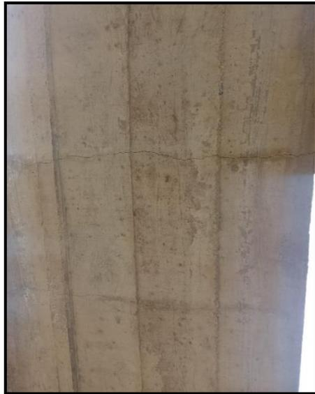
**Figura 1916:** Fisuras en el interior de la escalera.
