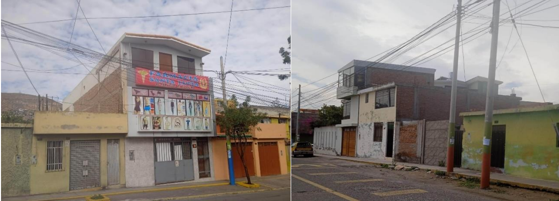
Viviendas construidas con ladrillo artesanal King King
