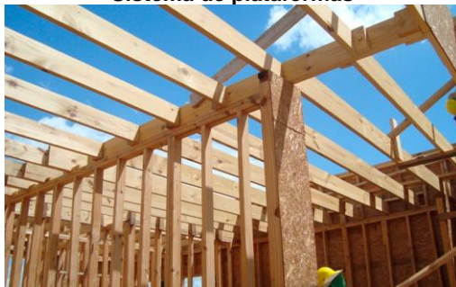
Sistema de vigas y postes
