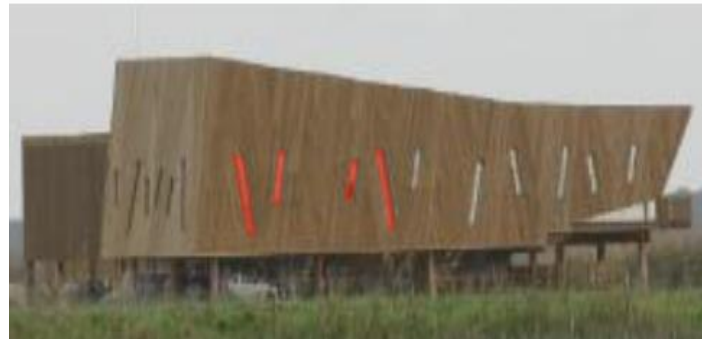
VISTA LATERAL DE LA EDIFICACIÓN
