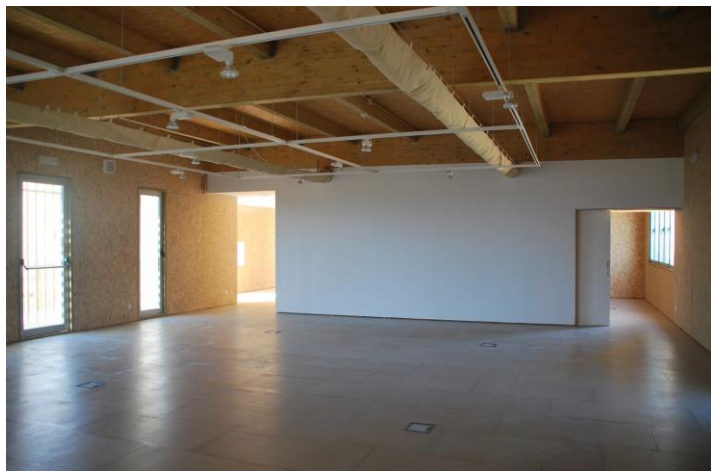
Vista interior de la edificación
