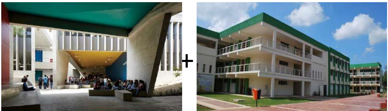
Figura 63: Fotos de comparación de infraestructura Ejemplo Fuente: Fotografía MINEDU 2019
