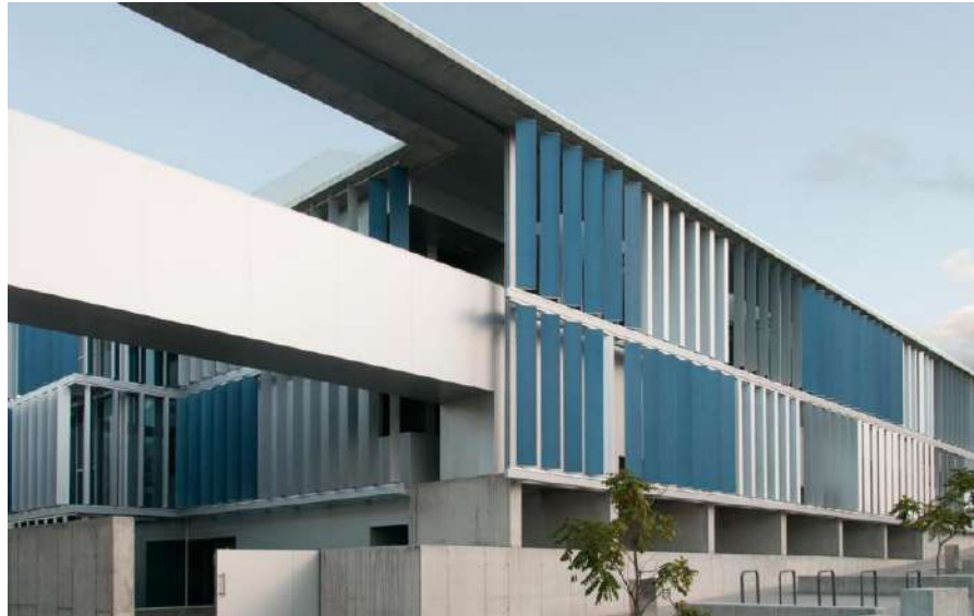
Figura 20: Lamas de hormigón regulables Fuente: Lamas de protección solar Edificio pasarela
