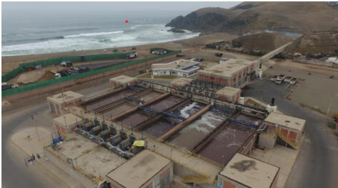
La Planta de Tratamiento de Aguas Residuales de La Chira
