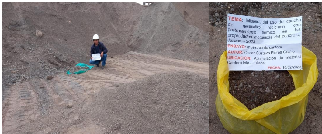
Foto 10. Extracción de agregados de la cantera
