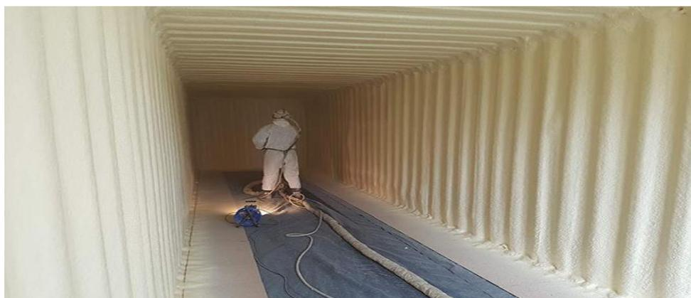
*Nota:* Es necesario recubrir el contenedor con espuma plástica para su impermeabilización y cuidado.
