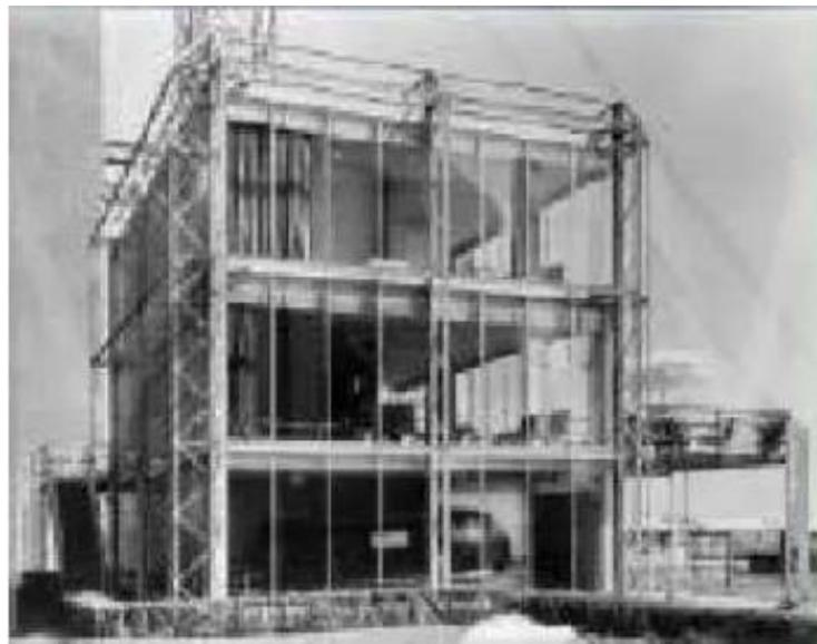
*Nota.* Anderson, crea las casas prefabricadas, estas casas estaban pensadas para poder moverlas de sitio “fácilmente”, ya que se mantenían sobre un gran soporte con ruedas, que permitía engancharlas a un camión para trasladarlas de lugar. <https://n9.cl/wuolb>
