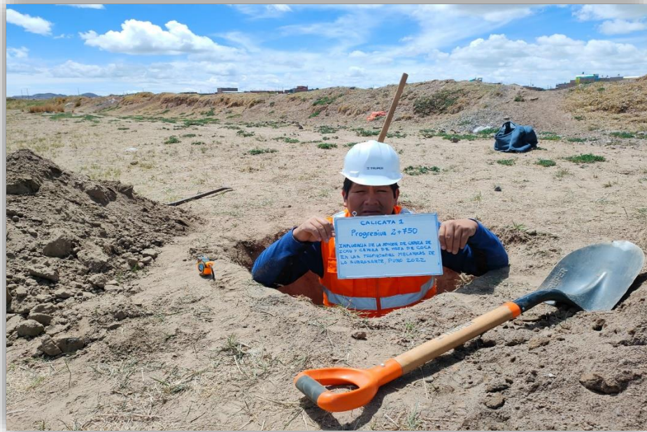
Figura 34 Calicata 1 en la progresiva 2 +750
