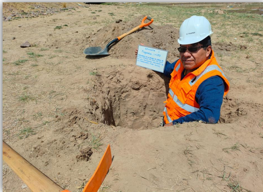
Figura 35 Calicata 2 en la progresiva 2 +750
