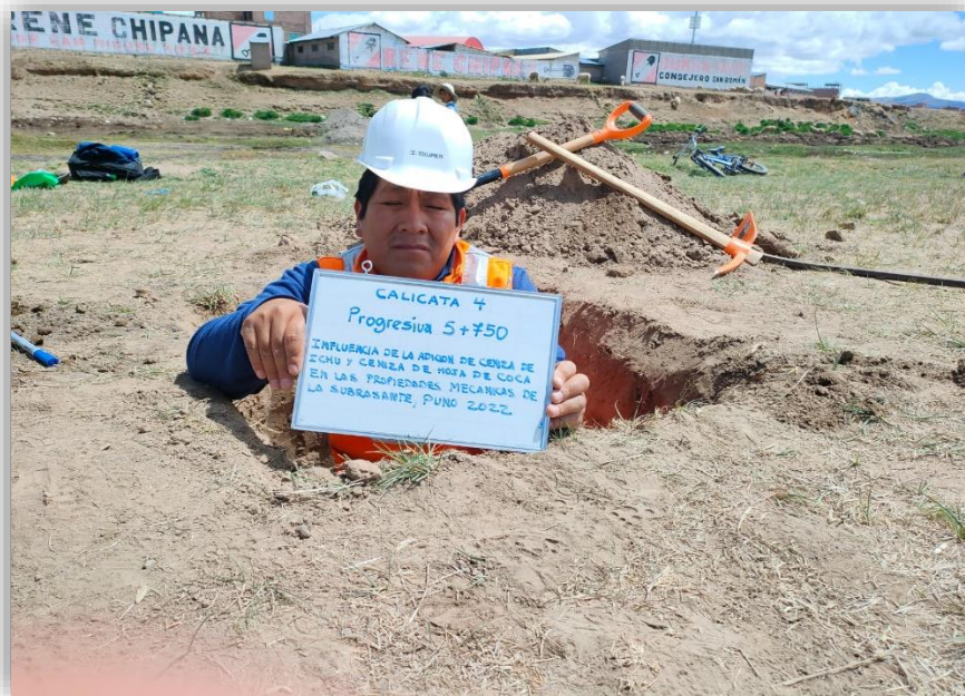
Figura 36 Calicata 4 en la progresiva 5 +750
