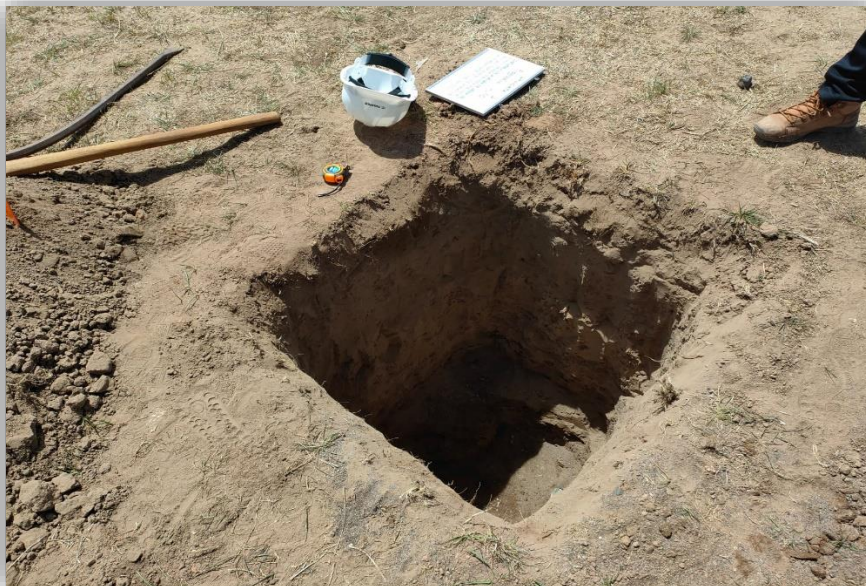
Figura 37 Profundidad de la calicata
