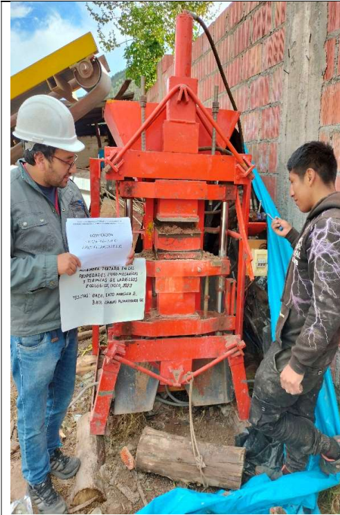
Fotografía 13: Elaboración de los ladrillos ecológicos con la prensa manual.
