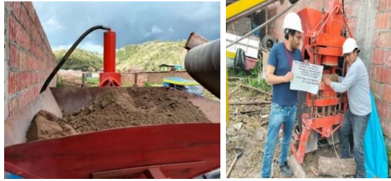
Figura 20 Elaboración de ladrillos ecológicos.
