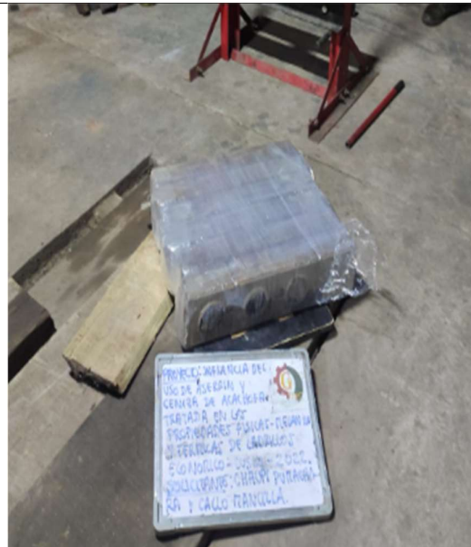
Fotografía 19: Protección con plástico de muretes y pilas para mantener su humedad.
