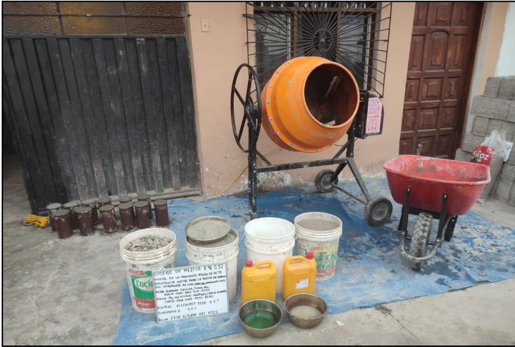
Imagen N°10: Preparación del concreto con los aditivos Sika ViscoCrete 4550 PE y SikaRapid 1
