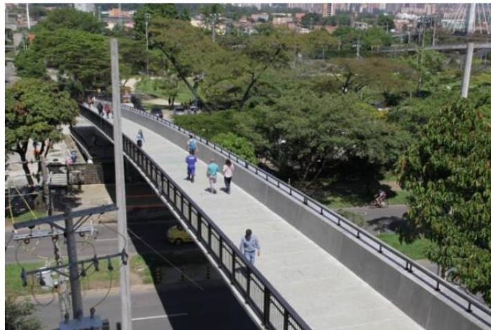
Figura 2. Tablero de recorrido del Puente Peatonal en Medellín
