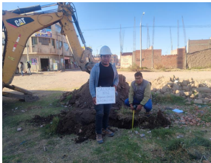
Figura 04: Calicata (C-2), progresiva: km 0+450.
