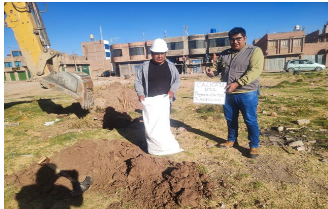
Figura 03: Calicata (C-1), progresiva: km 0+100.
