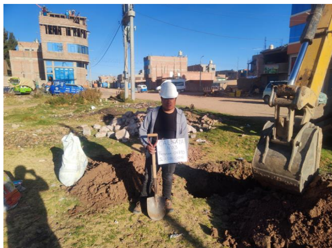
Figura 05: Calicata (C-3), progresiva: km 0+710.
