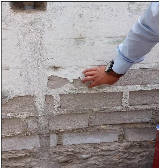
*Figura N°29: Deterioro por humedad en
