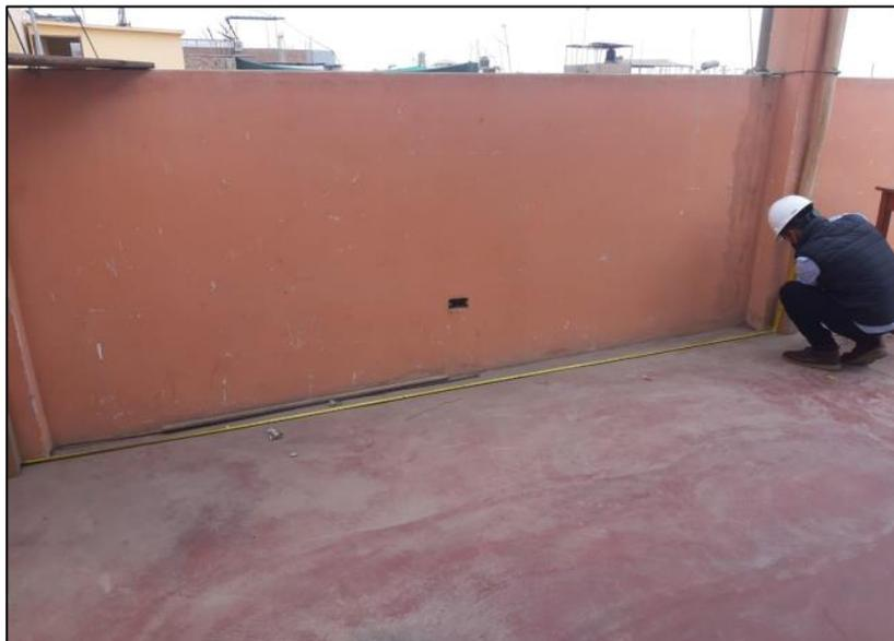
*Figura N°010: Toma de medidas de distanciamiento de Columnas en vivienda 1*
