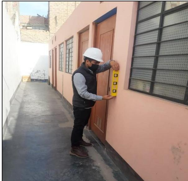
*Figura N°19: Verificación de verticalidad de muros en la vivienda 3 la vivienda N°3*
