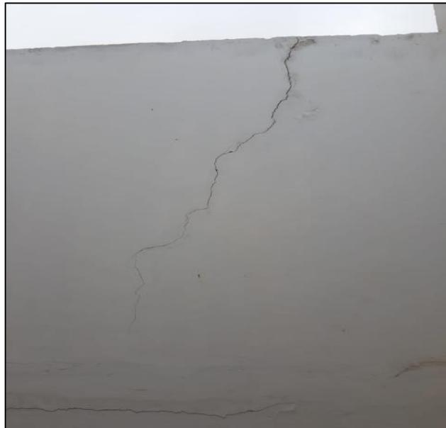
*Figura N°28: Daños en los muros, vivienda N° 1*
