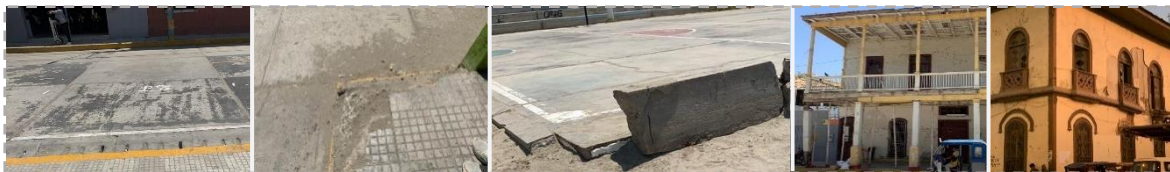
Figura N°15. Superficies en calzada, acera y playa, y superficies expuestas en fachadas y su estado de conservación.
