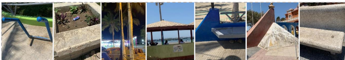
Figura N°16. Estado de conservación del mobiliario.
