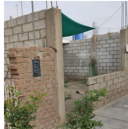
Paredes a mitad de construir
