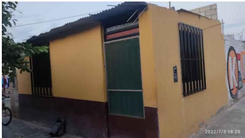
Fachada de modulo de vivienda
