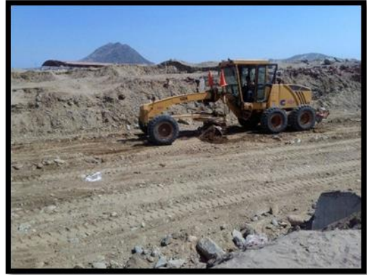
Imagen N°4: Trabajos de mejoramiento del cauce - quebrada San Idelfonso.
