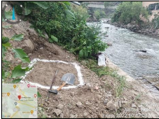
IMAGEN N 01: Se observa el trazo de la calicata a extraer de 1.0 x 1.0 m, para conocer los parámetros del suelo.
