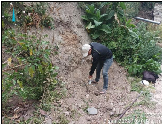
IMAGEN N 02: Se evidencian trabajos de limpieza de malezas y excavación con herramientas manuales para extracción de calicata.
