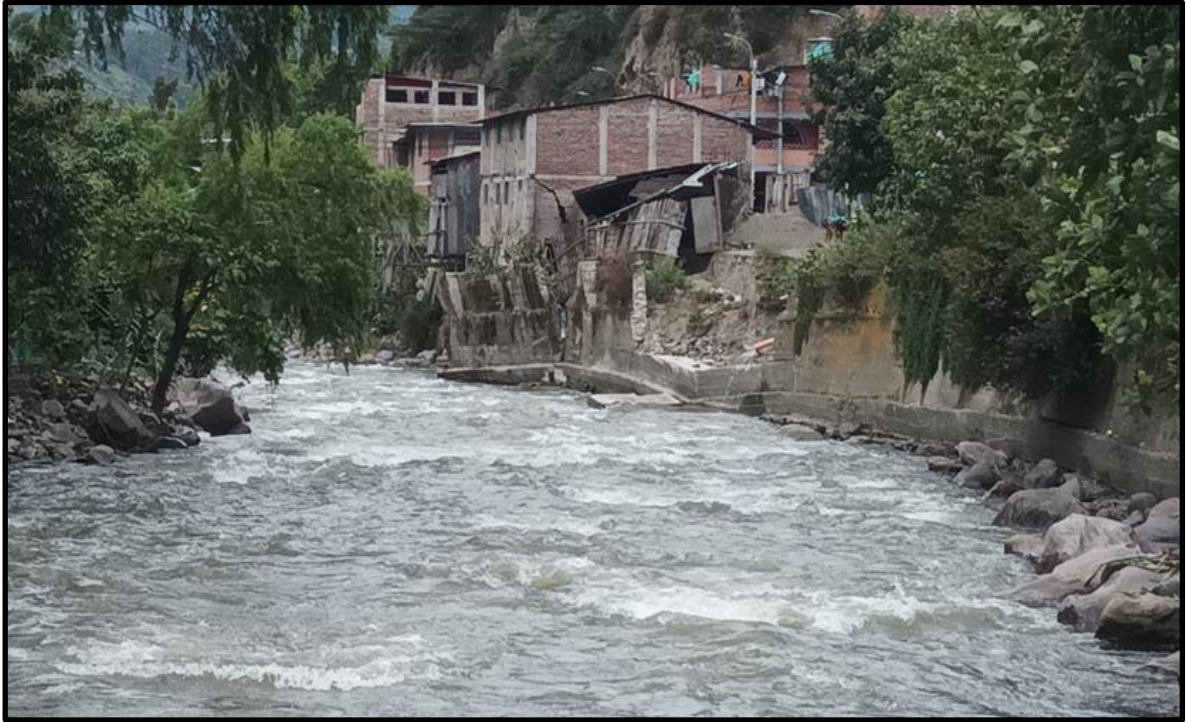
Figura 21. En esta imagen se aprecia el muro y las viviendas colapsadas.
