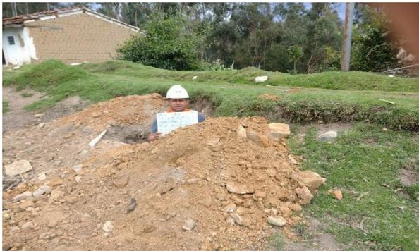
Se realizó la excavación y extracción de la tercera muestra de la calicata N° 03, realizado en el kilómetro 0+170.
