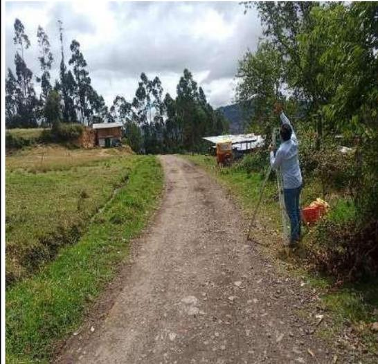
**FOTOGRAFÍA N° 08:** Levantamiento topográfico para la red de distribución
