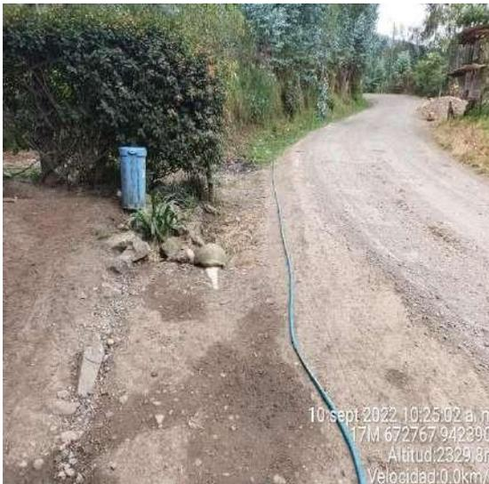
**FOTOGRAFÍA N° 14:** conexiones precarias con manguera a lo largo de la vía
