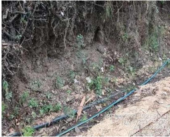
**FOTOGRAFÍA N° 12:** La línea de distribución no está enterrada completamente además de presentar fugas
