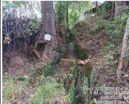
**FOTOGRAFÍA N° 13:** Conexiones precarias con manguera desde una acequia
