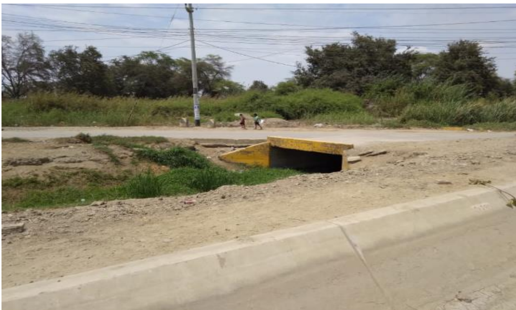
Foto actual del Dren Comas del caserío de Rinconada
