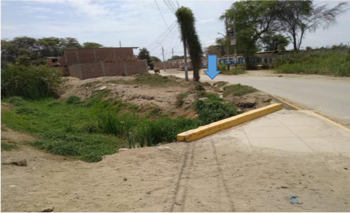
Foto donde se logra apreciar la cuneta existente de drenaje para finalmente desembocar al dren Comas
