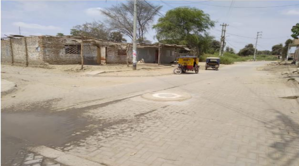
Foto de la calle Paredones con la Calle Comercio principal en estas calles recibirían el flujo total del agua pluvial para finalmente ser evacuado al dren comas
