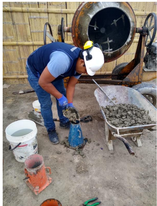
Ensayo asentamiento o prueba de slump con el cono de
