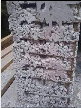
Figura 2. Segregación del concreto fuente: fuente: NTP 339.03
