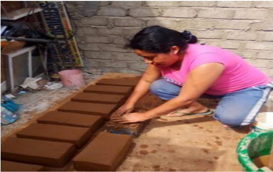
Fuente: Fotografía tomada en proceso de fabricación de adobe
