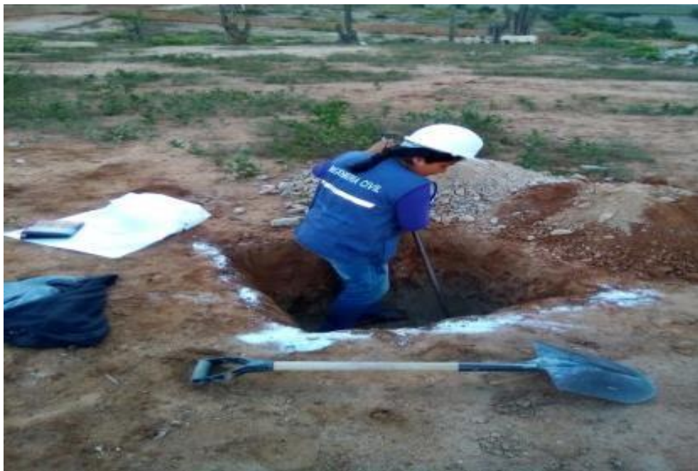
Figura 3: Calicata, coordenadas 8^{\circ}46'38.48'' S y 77^{\circ}51'53.12'' O.
