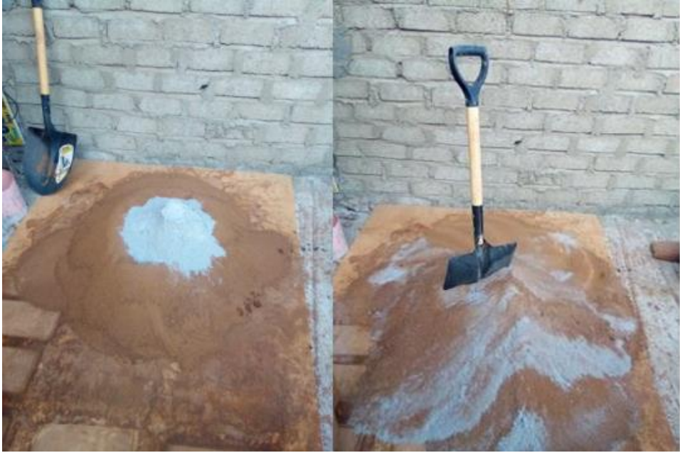
Fuente: Fotografía tomada en proceso de mezcla
