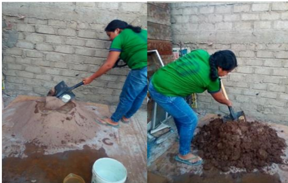
Fuente: Fotografía tomada en proceso de mezcla
