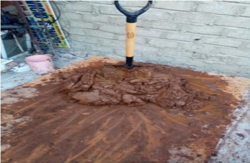
Fuente: Fotografía tomada en proceso de mezcla
