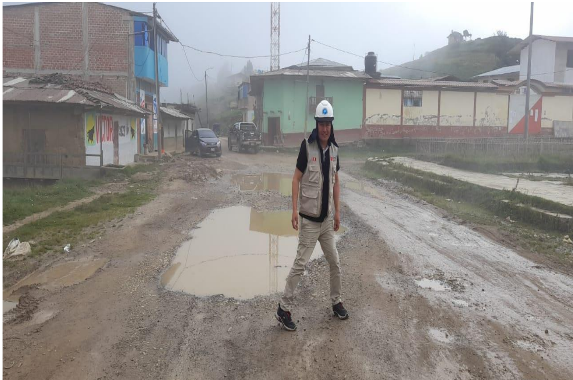
Figura 07: Vista de la vía sin presencia de cunetas para evacuar las aguas de lluvia.
