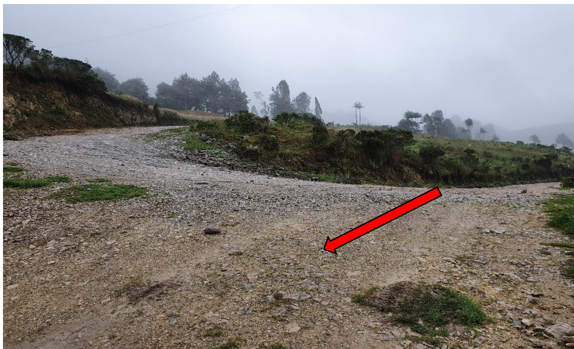
Figura 17: Vista de caminos rurales que intersectan la carretera y que serán interrumpidos temporalmente.
