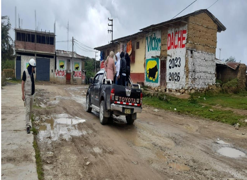
FIGURA 03: Vista de empozamiento de agua en vía.
