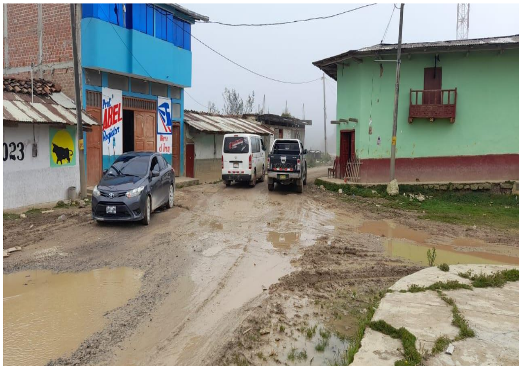
FIGURA 02: Vista de charcos de lodo en la vía.
