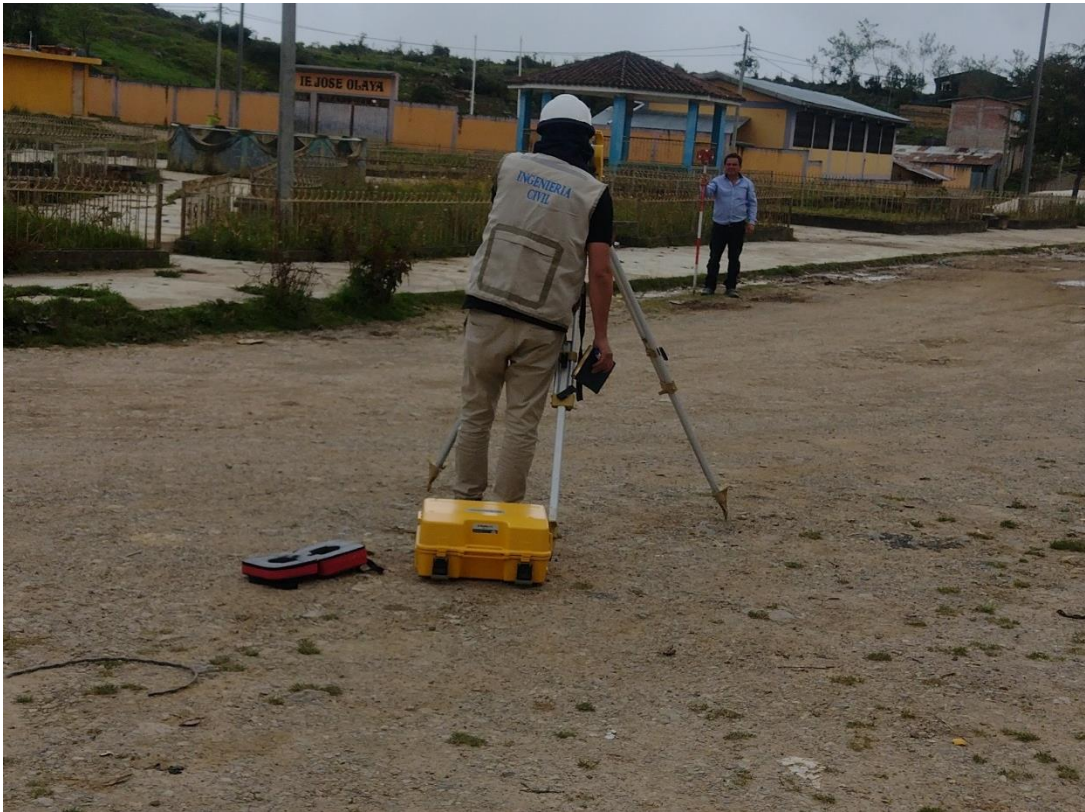
Figura 15: Ubicación de los respectivos prismas para la toma de puntos.
