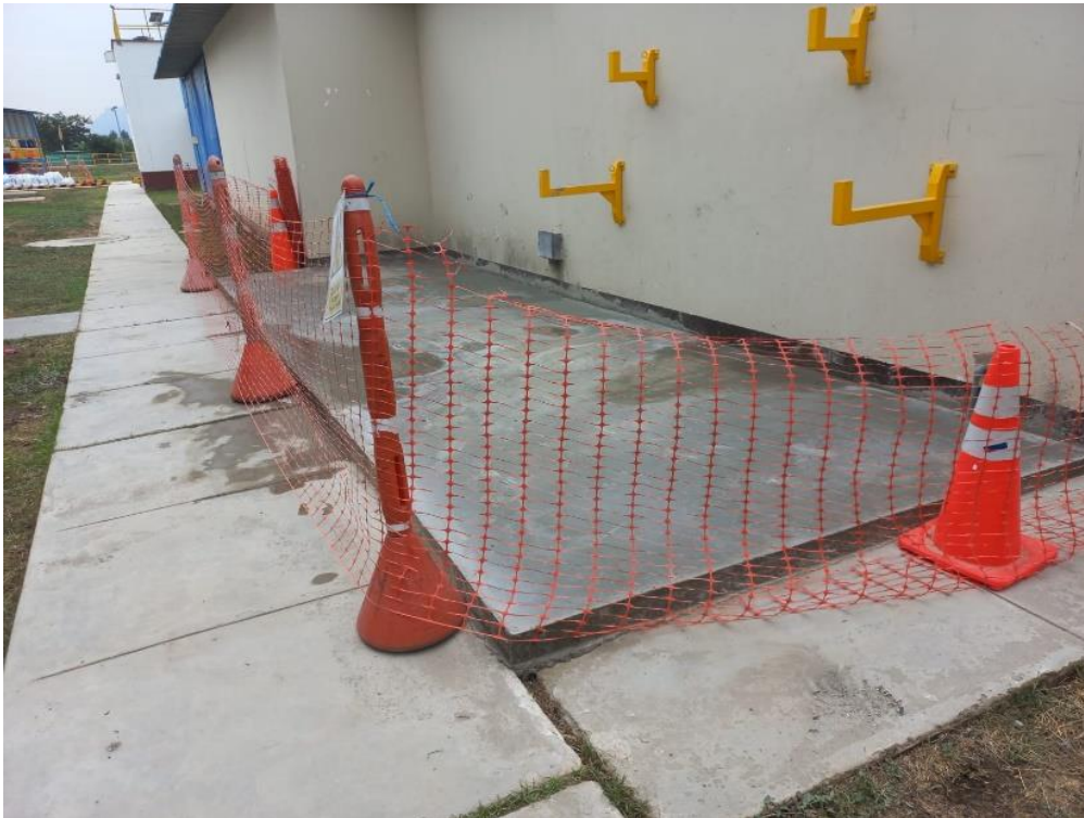
Figura 15. Foto Zona de Montaje asfaltada
