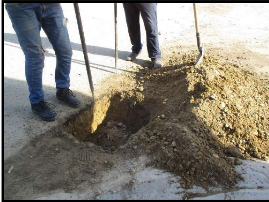
FOTOGRAFIA 07: CALICATA Nº 03 – REALIZANDO EXCAVACION A CIELO ABIERTO
