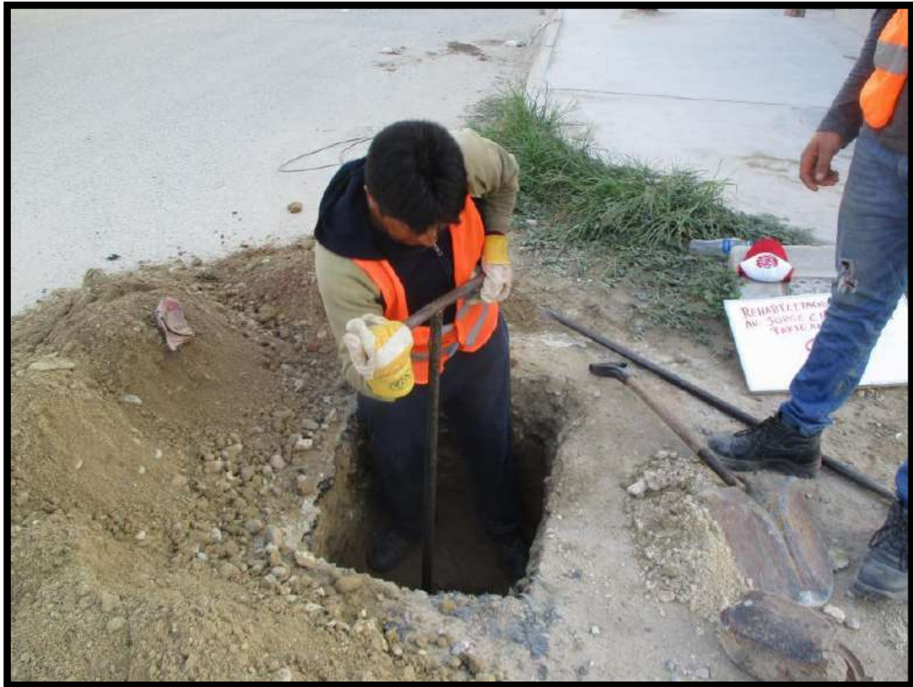
FOTOGRAFIA 05: CALICATA Nº 01 – PROFUNDIZANDO EXCAVACION CON BARRENO
