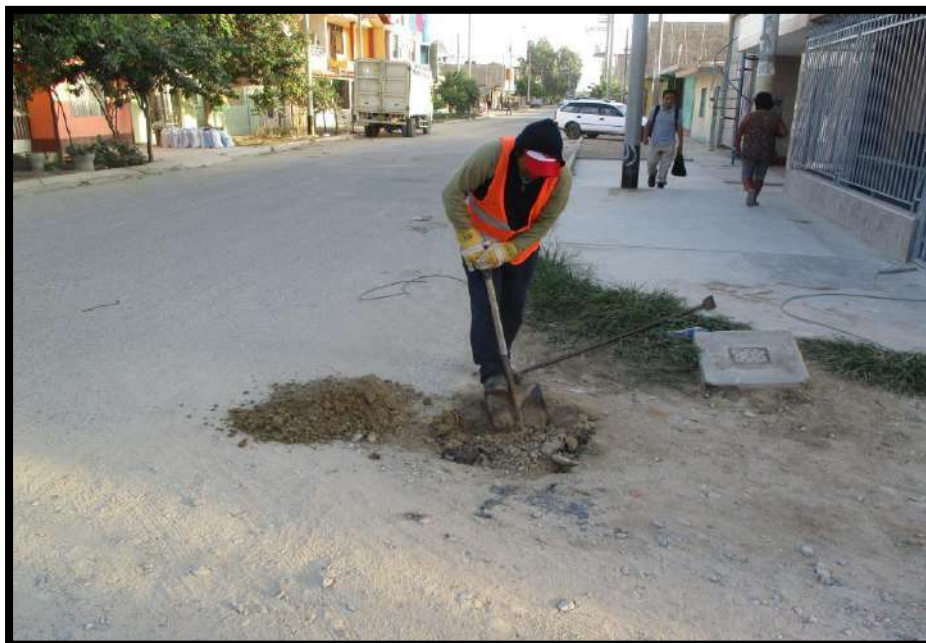
FOTOGRAFIA 04: CALICATA N° 01 – REALIZANDO EXCAVACION A CIELO ABIERTO
