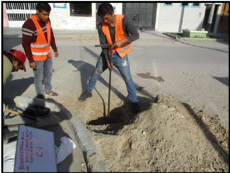
FOTOGRAFIA 06: CALICATA Nº 02 – PROFUNDIZANDO EXCAVACION CON BARRENO
