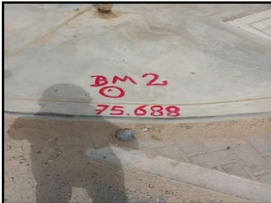
FOTOGRAFIA 08: TRAZO Y REPLANTEO DE OBRA.
