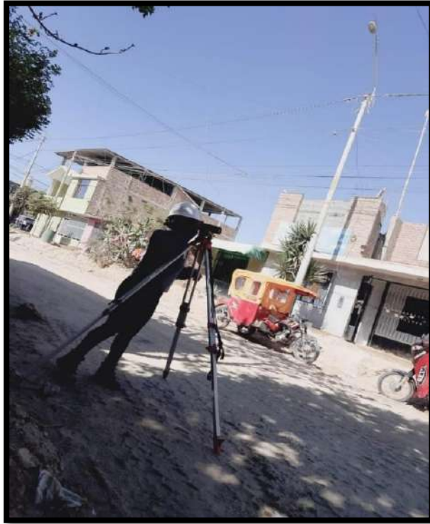
FOTOGRAFIA 09: LEVANTAMIENTO TOPOGRAFICO EN LA ZONA DE ESTUDIO
