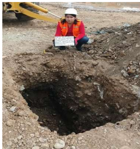
Figura 5: calicata 01 Fuente: Elaboración propia
