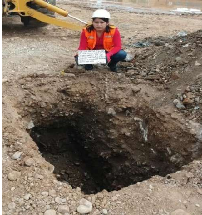
Imagen 3: Se realizó la excavación de la primera calicata de 1.50m
