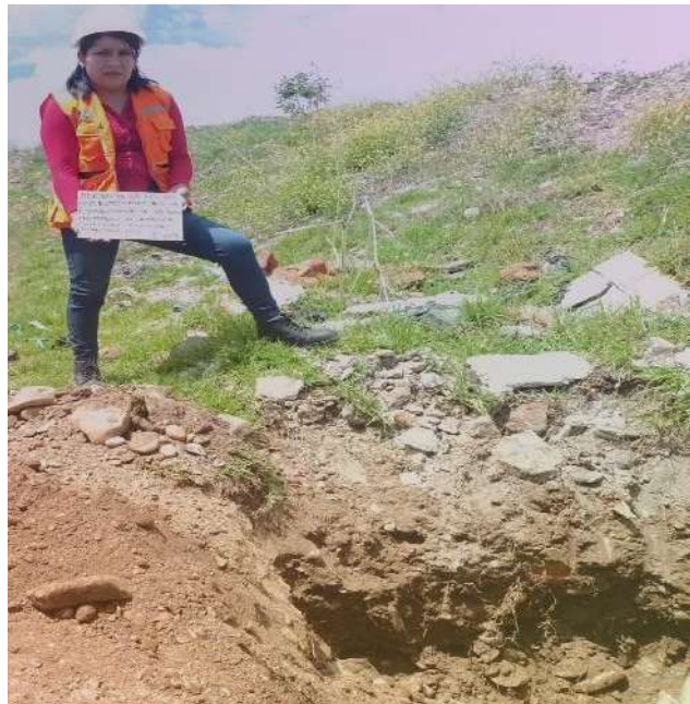
Imagen 4: se realizó la excavación de la segunda calicata de 1.50m
