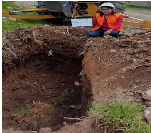
Figura 7: calicata 03 Fuente: Elaboración propia
