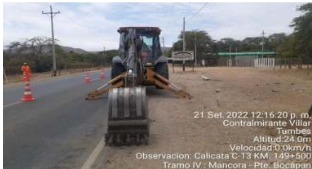
Fotografía N°13 – Calicata C-13 Km. 149+500
