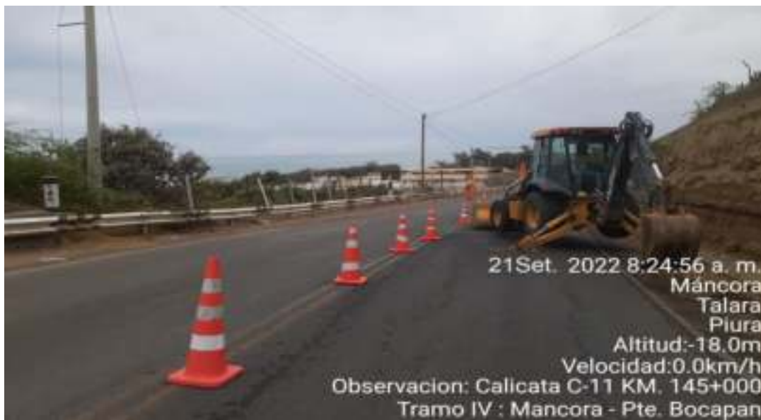
Fotografía N°11 – Calicata C-11 Km. 145+000
