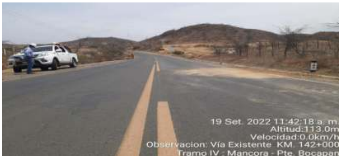
Vía Existente Km 142+000
