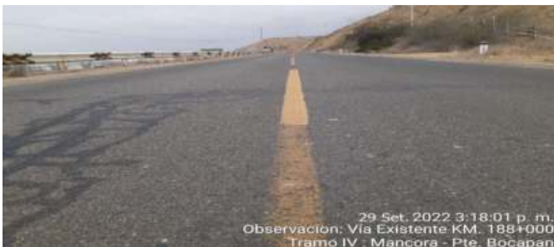
Vía Existente Km 188+000
