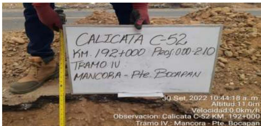
Fotografía N°52 – Calicata C-52 Km. 192+000
