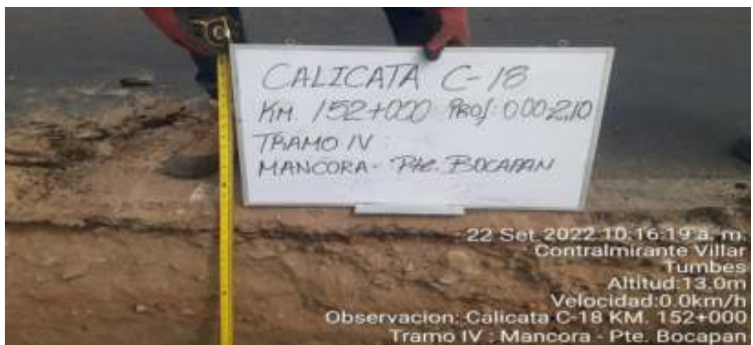
Fotografía N°18 – Calicata C-18 Km. 152+000
