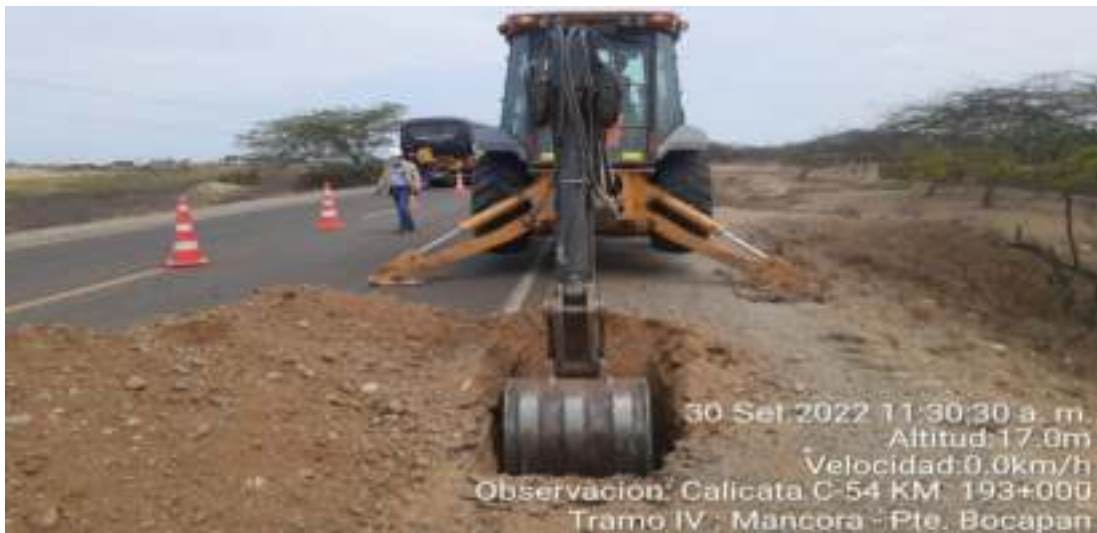
Fotografía N°54 – Calicata C-54 Km. 193+000
