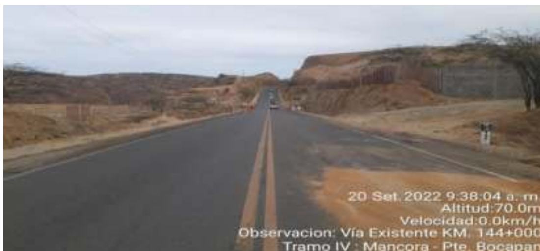
Vía Existente Km 144+000
