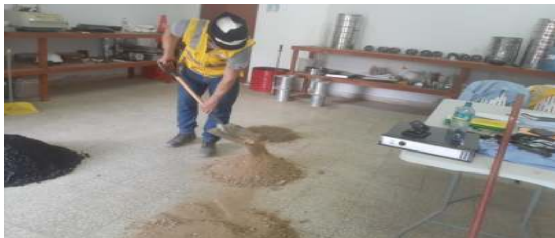
Base Granular Existente
