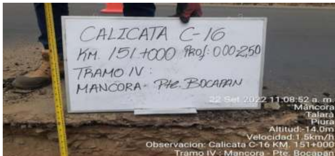
Fotografía N°16 – Calicata C-16 Km. 151+000
