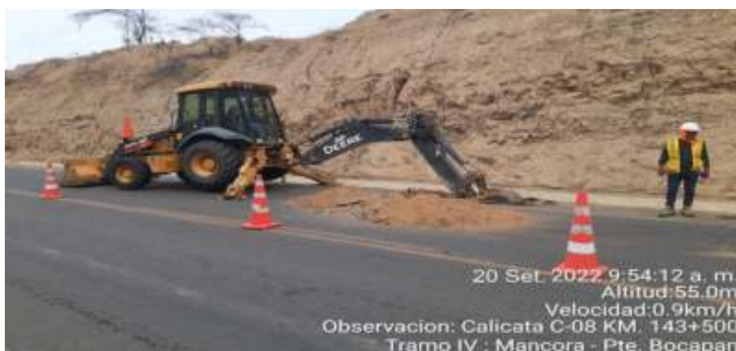
Fotografía N°8 – Calicata C-8 Km. 143+500
