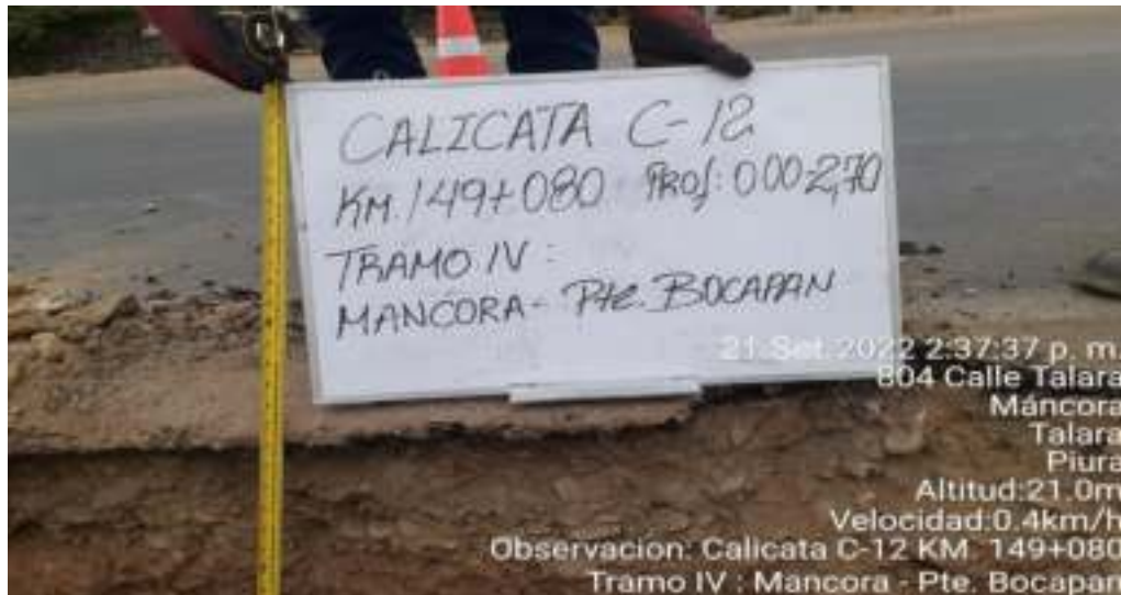
Fotografía N°12 – Calicata C-12 Km. 149+080
