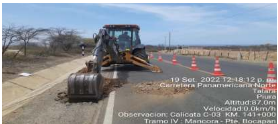
Fotografía N°3 – Calicata C-3 Km. 141+000
