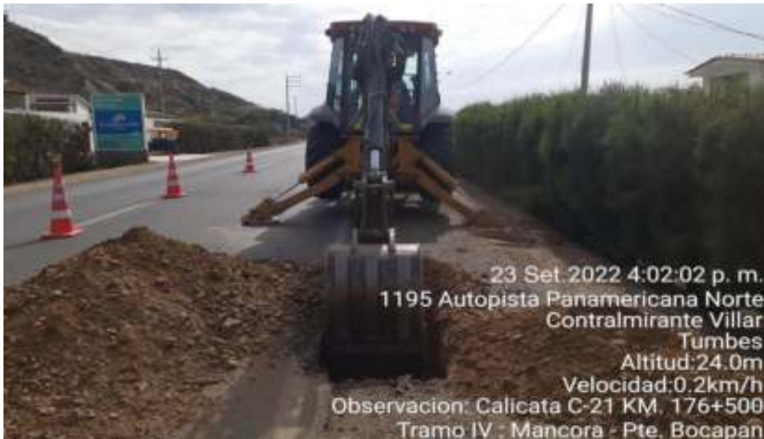
Fotografía N°21 – Calicata C-21 Km. 176+500
