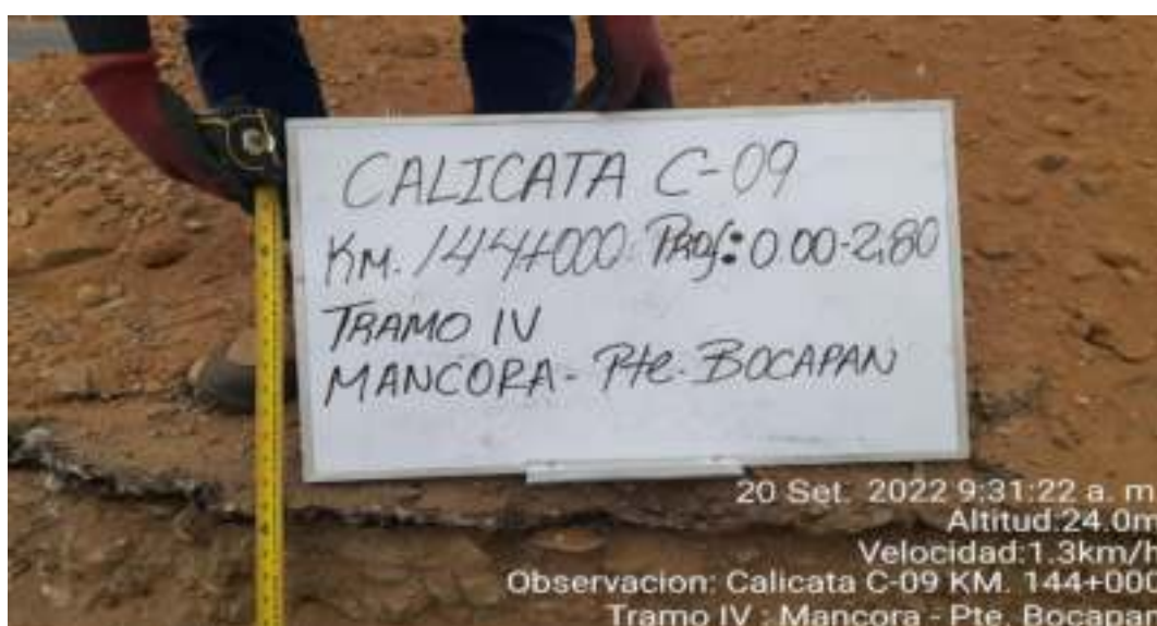
Fotografía N°9 – Calicata C-9 Km. 144+000
