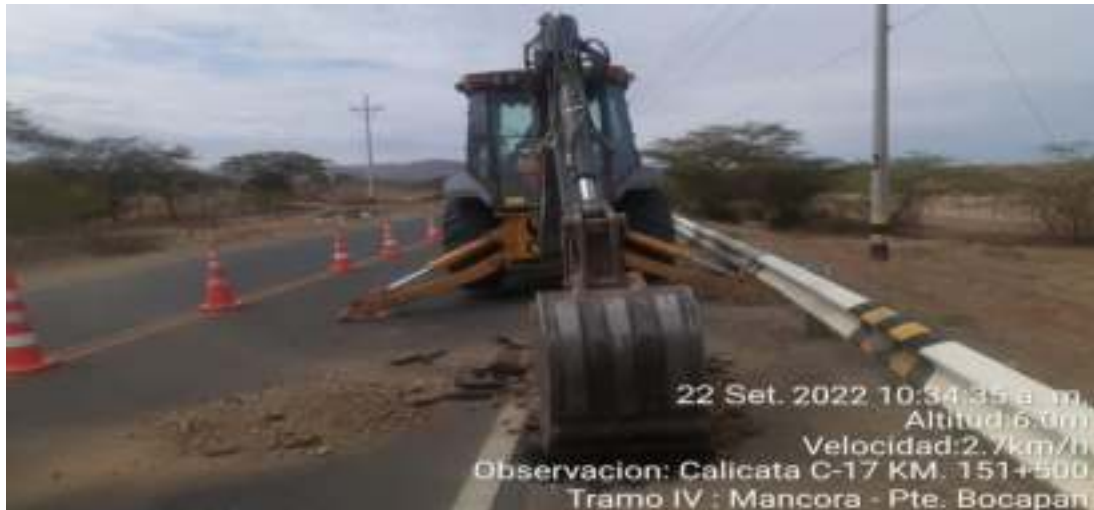
Fotografía N°17– Calicata C-17 Km. 151+500
