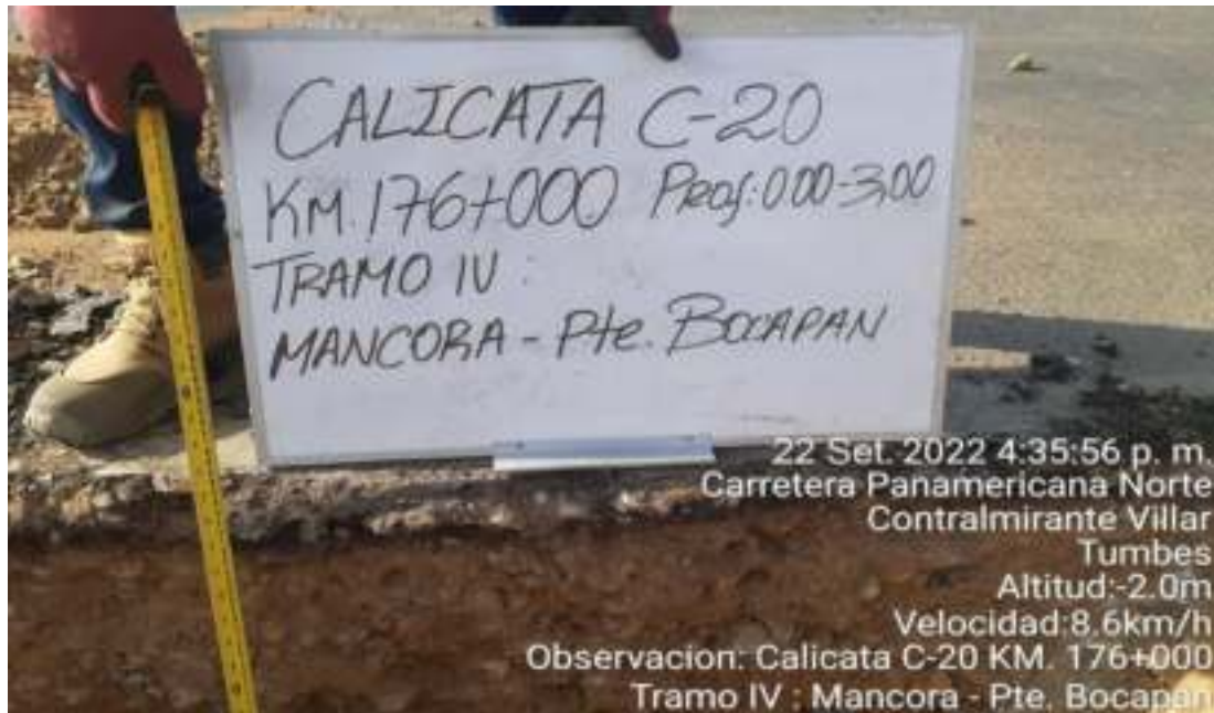
Fotografía N°20 – Calicata C-20 Km. 176+000
