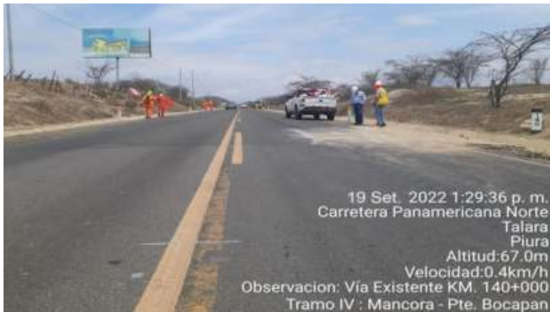
Vía Existente Km 140+000
