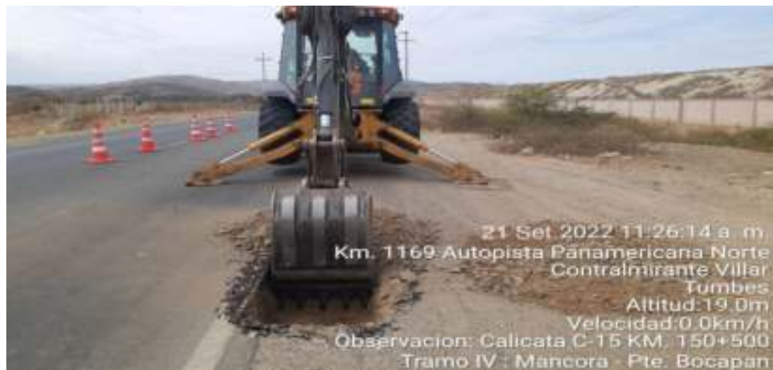
Fotografía N°15 – Calicata C-15 Km. 150+500
