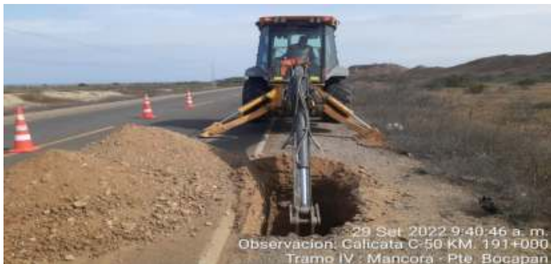
Fotografía N°50 – Calicata C-50 Km. 191+000
