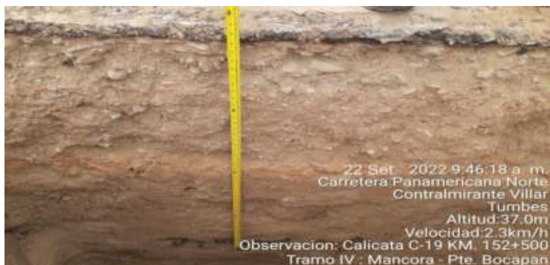
Fotografía N°19 – Calicata C-19 Km. 152+500
