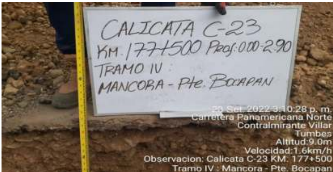
Fotografía N°23 – Calicata C-23 Km. 177+500
