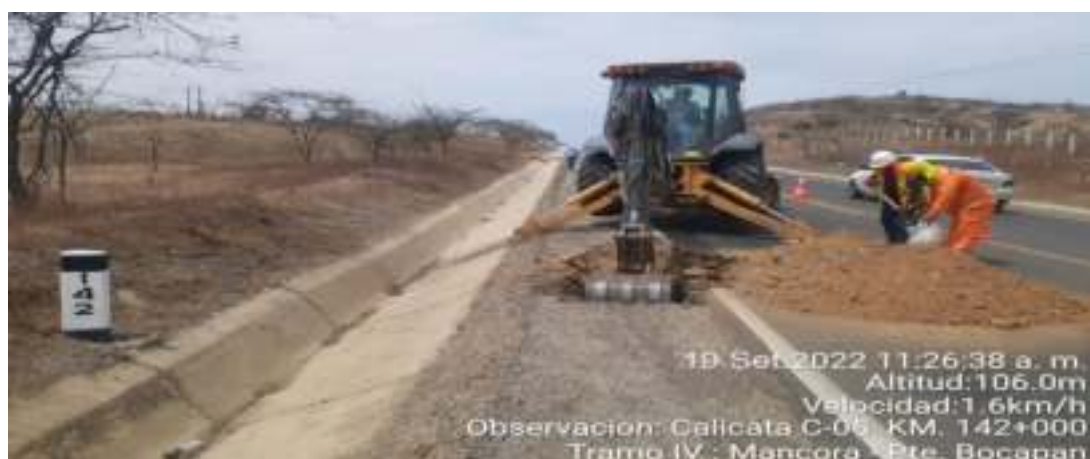
Fotografía N°5 – Calicata C-5 Km. 142+000
