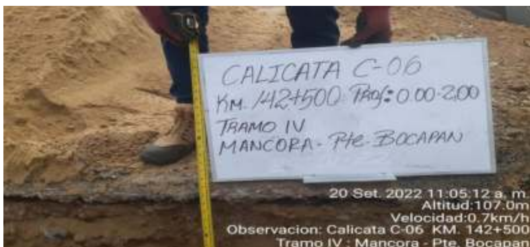
Fotografía N°6 – Calicata C-6 Km. 142+500
