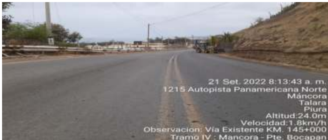
Vía Existente Km 145+000
