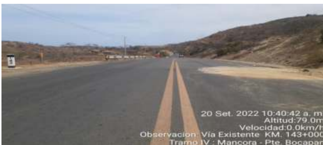
Vía Existente Km 143+000
