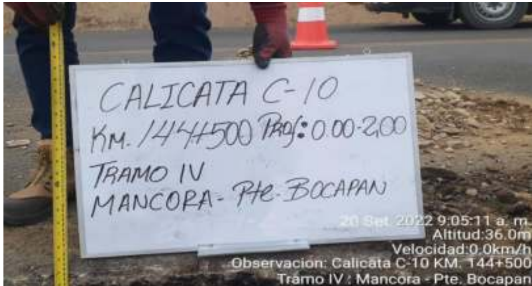
Fotografía N°10 – Calicata C-10 Km. 144+500
