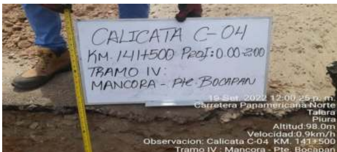
Fotografía N°4 – Calicata C-4 Km. 141+500
