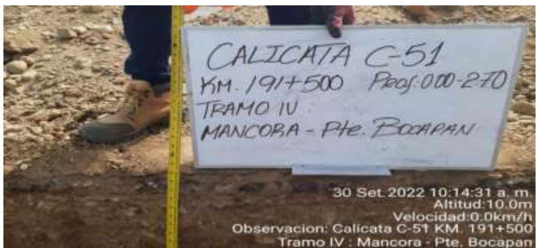
Fotografía N°51 – Calicata C-51 Km. 191+500
