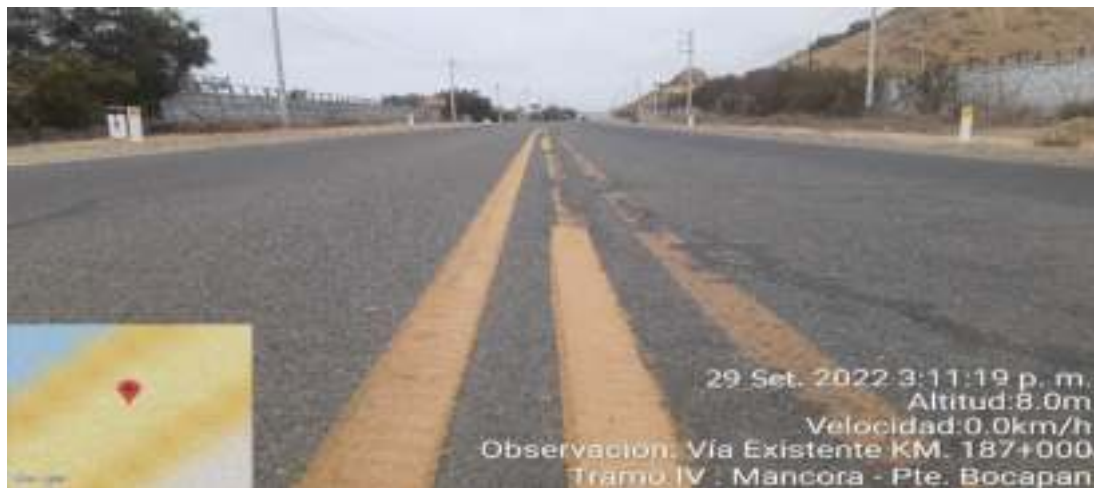
Vía Existente Km 187+000
