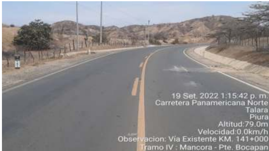
Vía Existente Km 141+000
