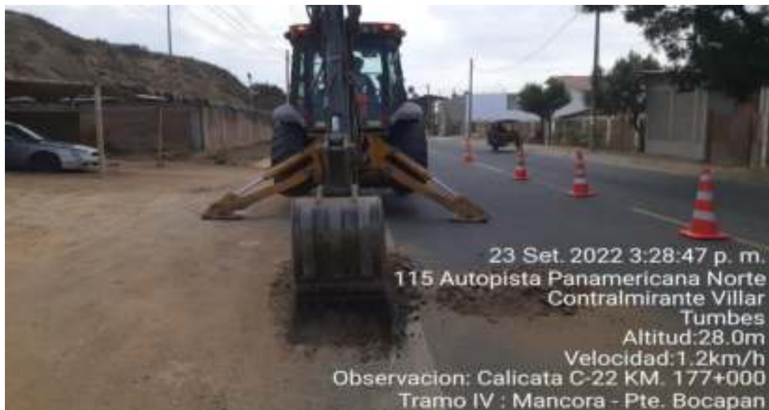
Fotografía N°22 – Calicata C-22 Km. 177+000
