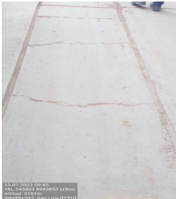
Figura 15. Vista de parche grande
