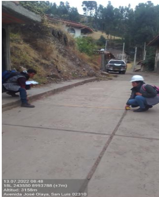
Figura 1. vista de ancho del paño.
