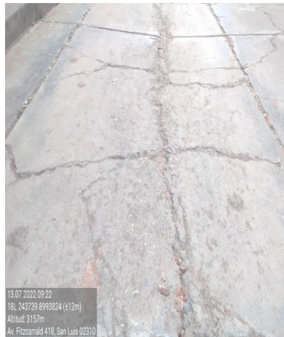
Figura 8. Vista de losas divididas
