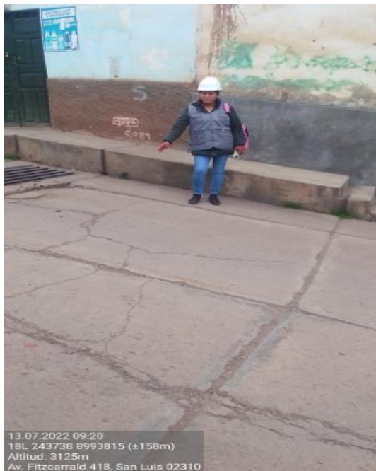
Figura 7. Vista de losas divididas
