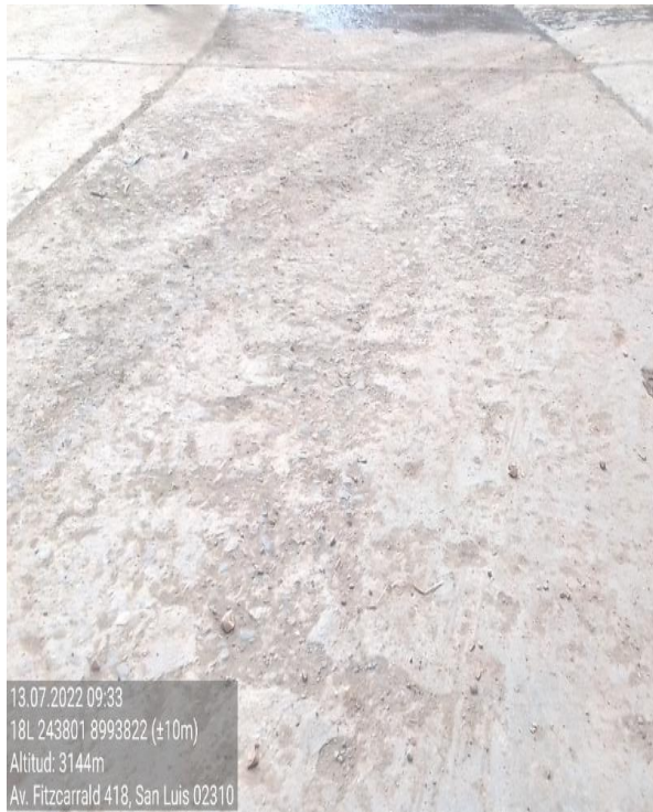
Figura 5. Vista de pulimiento de agregado
