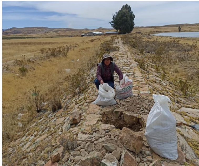
Figura 11. Toma de muestra del suelo del dique de tierra
