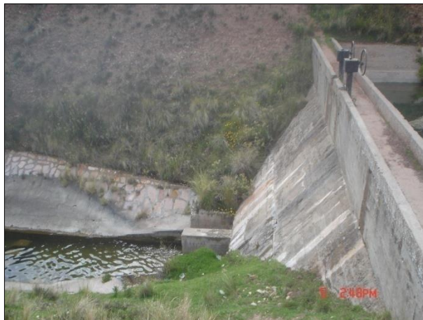
Foto 1: Presa de concreto Cotarsaya
