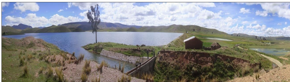
Foto 2: Vista panorámica de la represa, dique de tierra de la presa Cotarsaya
