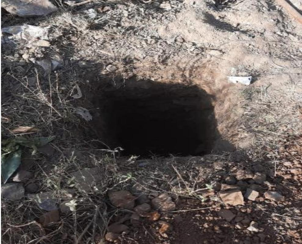
Imagen 2. Excavación de la calicata C-01
