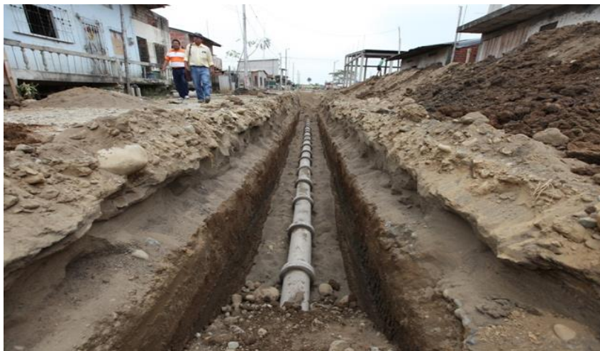
Figura 02. Construcción de un alcantarillado
