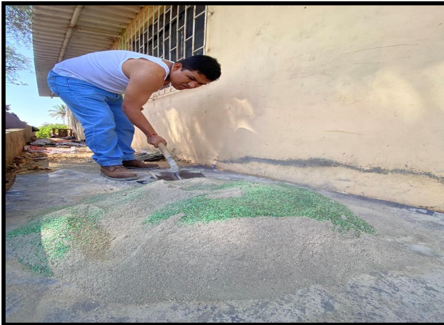
FIGURA N°04: Proceso de mezclado con cemento, arena y plástico PET.
