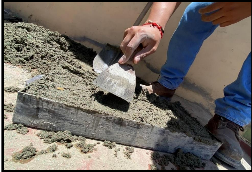
FIGURA N°05: Preparación del ladrillo ecológico con Plástico (PET) en moldes.
