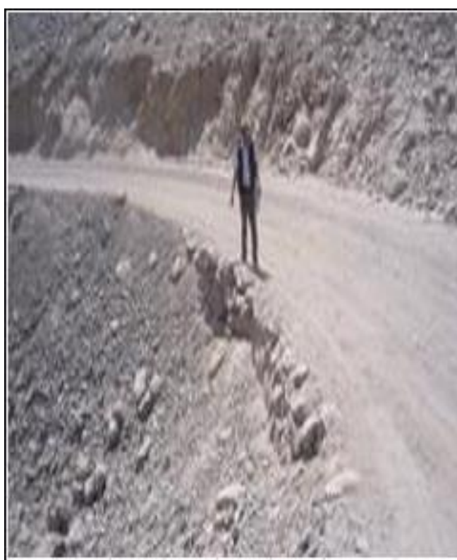
MURO DE CONTENCION EXISTENTE PROGRESIVA 7 + 110.
