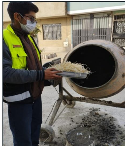
Vaciado de concreto con fibras
