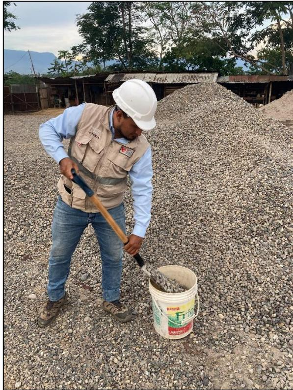
**FOTO N°1: Extracción de agregado fino**
