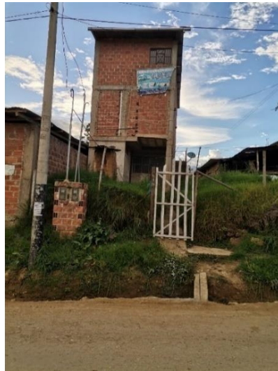
Imagen N° 3: Vivienda construida sin un previo diseño estructural en la localidad de Chachapoyas
